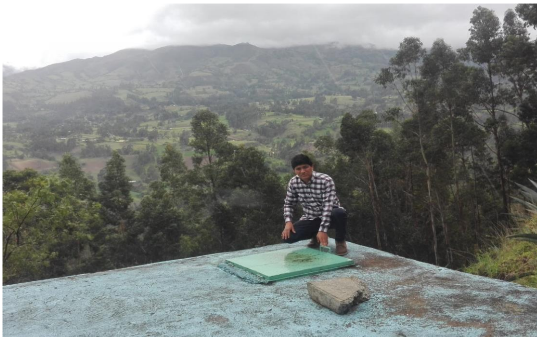
Ilustración 26: Reservorio de almacenamiento de agua para el consumo humano.
