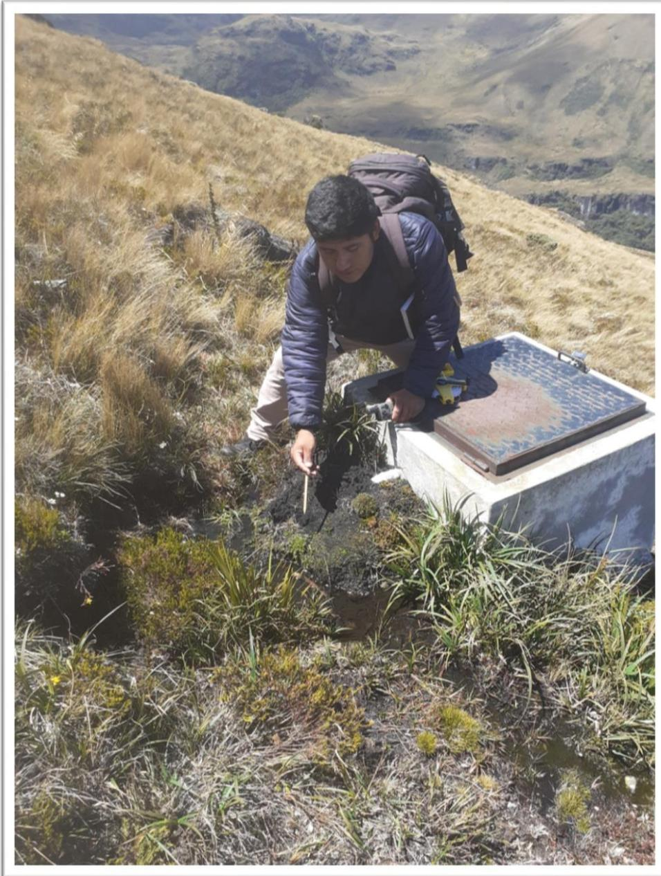
**En la fotografía se aprecia fugas de agua, que según el análisis es consecuencia de la alta presión hidráulica en la red.**
