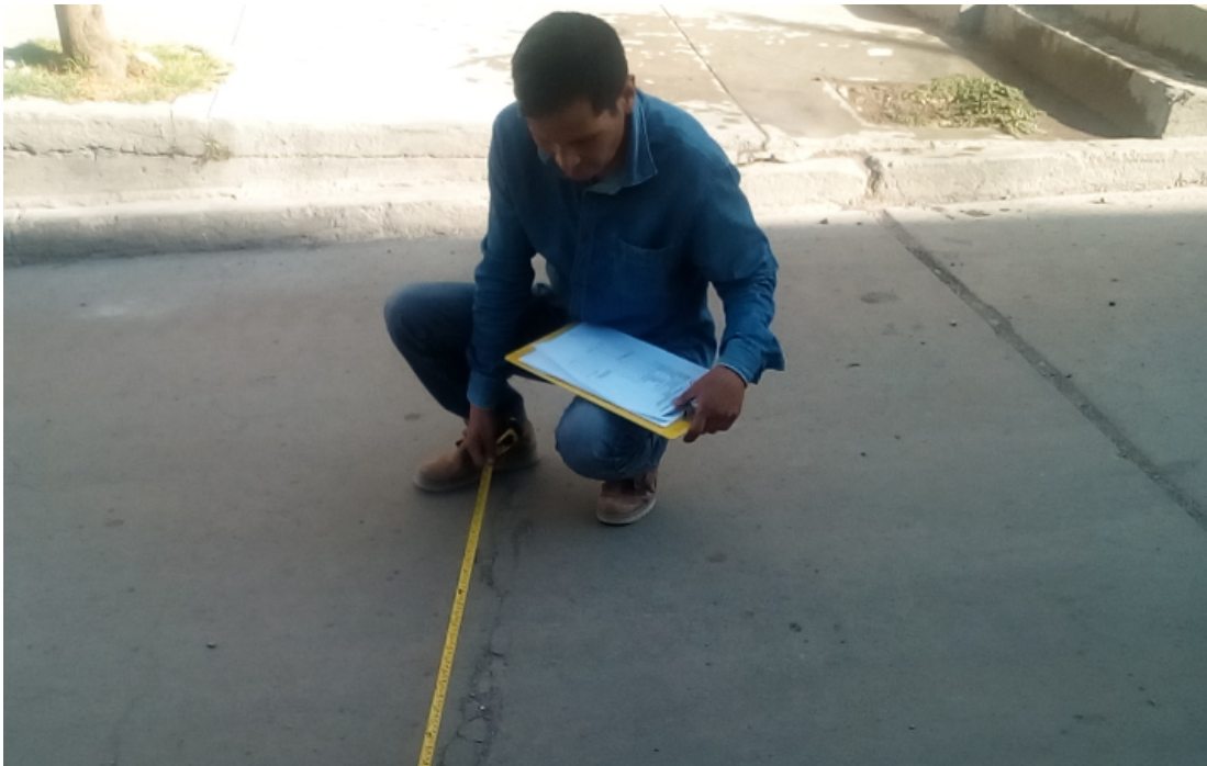
Fotografía 6: Patologías observadas en el pavimento evaluado.
