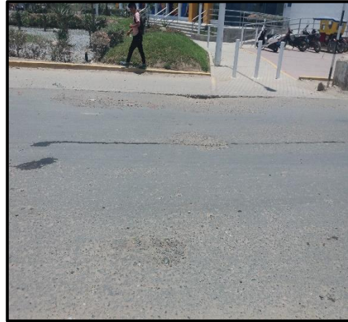
Av.chulucanas entre las progrecivas Km.0+000 al Km.0+670, donde podemos apreciar el Deterioro de capa asfáltica. Fuente propia
