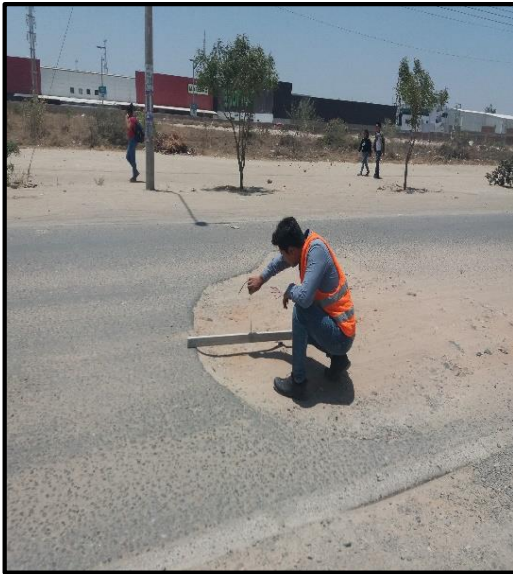
Av.chulucanas entre las progrecivas Km.0+000 al Km.0+670, donde podemos apreciar el Desprendimiento de Agregados de la Via. Fuente propia.
