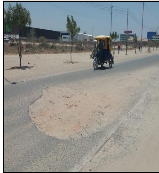
Av.chulucanas entre las progrecivas Km.0+000 al Km.0+670, donde podemos apreciar el Desprendimiento de Agregados de la Via. Fuente propia.
