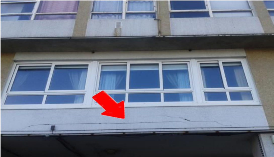
Figura 2.4: Agrietamiento Horizontal.
