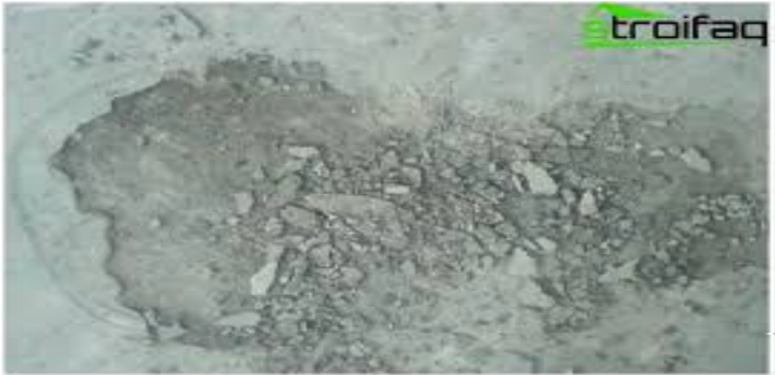
Figura 2.13: Delaminación del agregado. Fuente:(Imagen propia de investigación).
