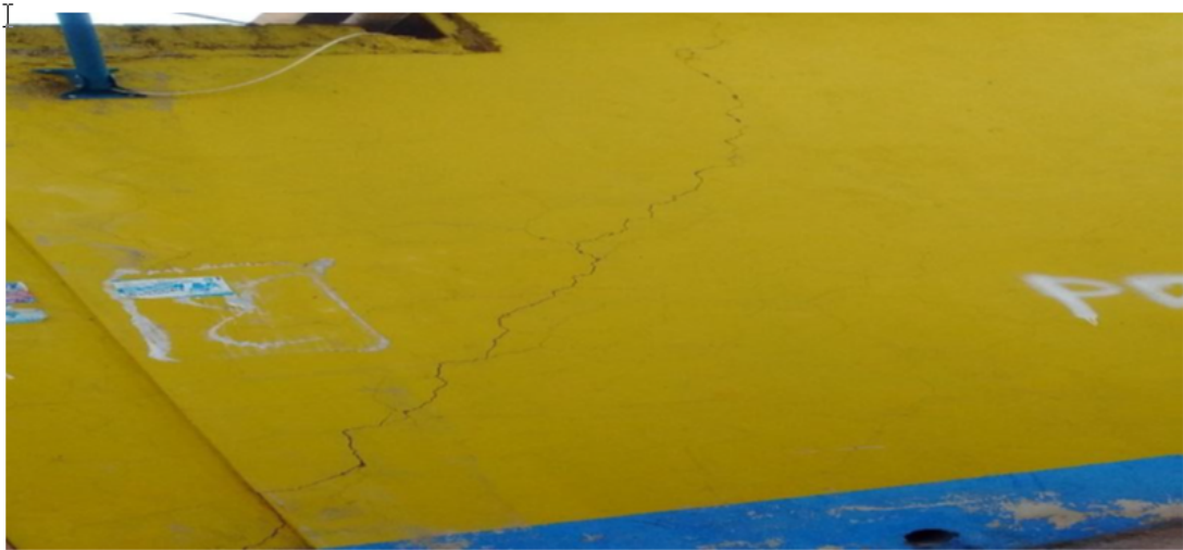
Figura 2.3: Agrietamiento diagonal.
