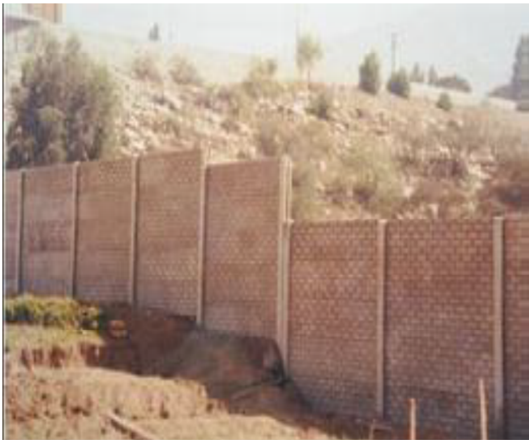
Figura 2.2: Muros no portantes.
