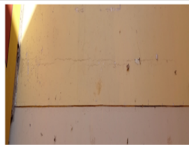
Figura 5.16: Gráfico de las patologías encontradas en la muestra 3
