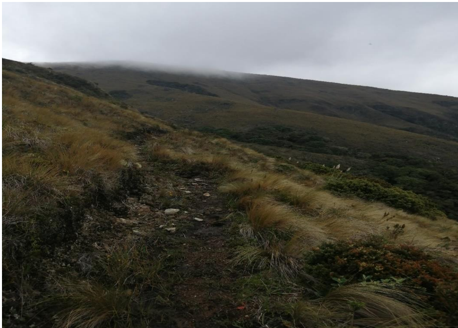
Imagen 7: Red de Conducción, Huella de la excavación para enterrar la tubería
