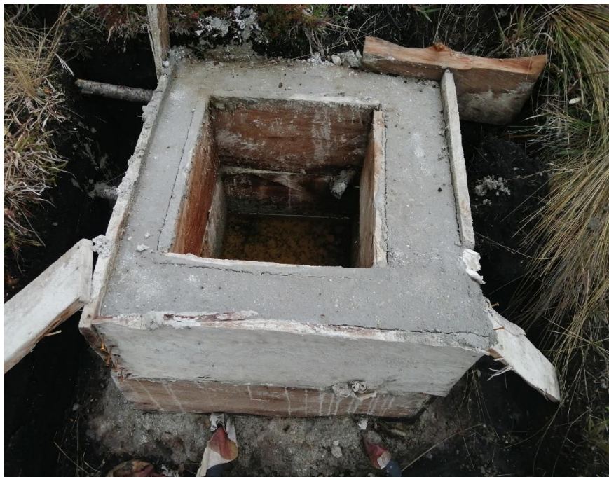
Imagen 9: Cámara Rompe Presión en línea de conducción en proceso de construcción
