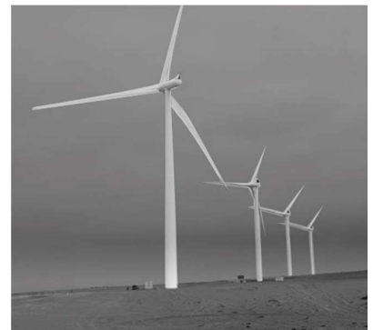
Figura 1. Parque eólico en Marcona.
