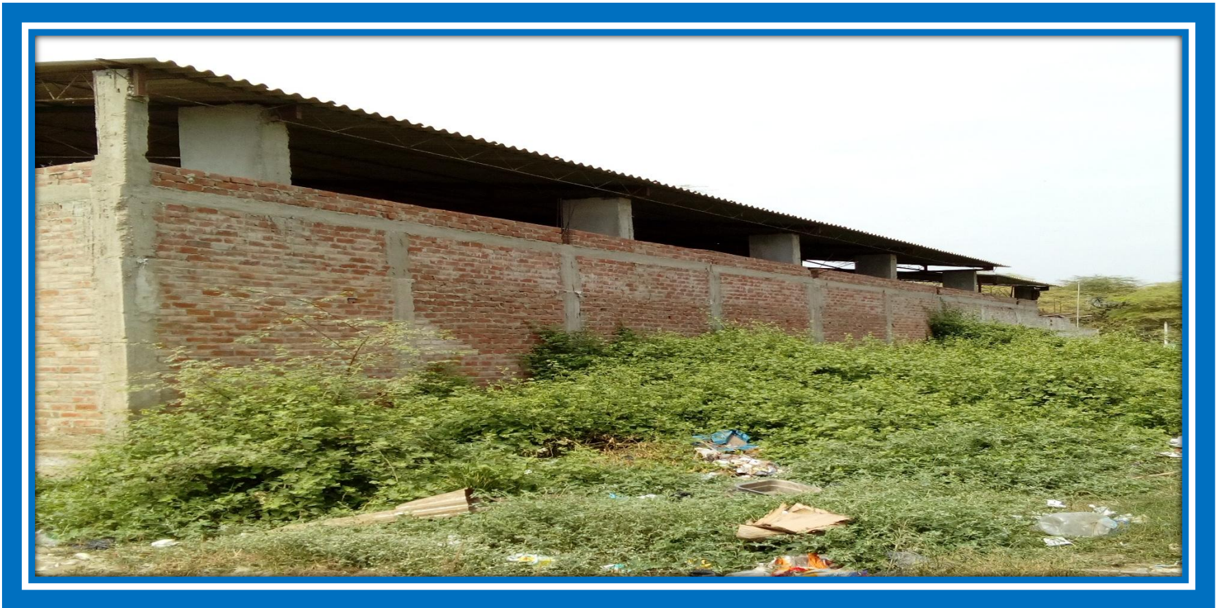
Imagen 5: Foto panorámica de la calle Adres Avelino Cáceres, del cerco perimétrico del local Bodas de caná en el AA.HH Lucas Cutivalú –Catacaos
