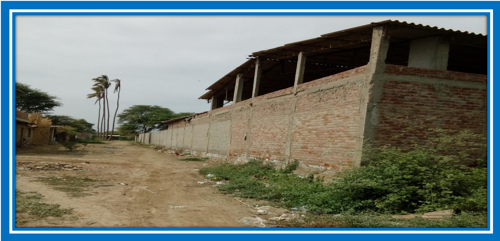
Imagen 4: Foto panorámica de la calle Paracas del cerco perimétrico del Local Bodas de Caná en el AA.HH Lucas Cutivalú-Catacaos
