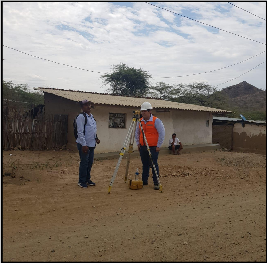
Figura 30: Levantamiento topográfico de las calles del proyecto. Fuente: Elaboración propia.
