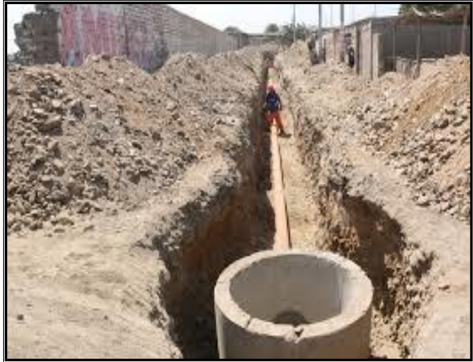
Figura 7: Buzón instalado en obra. Fuente: Elaboración Propia.
