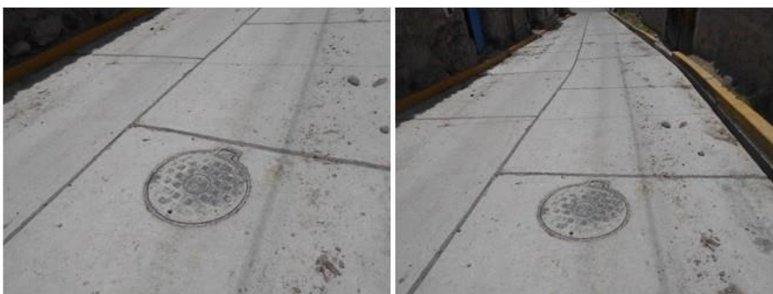
Figura 5.14: Vistas de busones recientes en las calles sin asfaltar que requieren cambiar.
