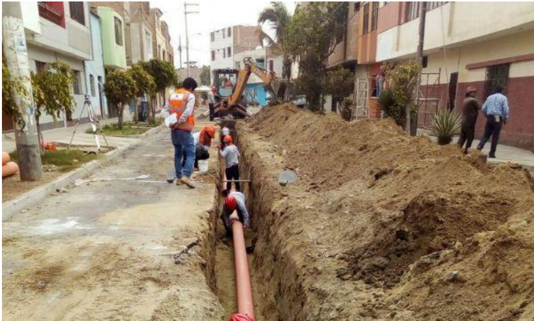
Figura 2.7: Instalación del Alcantarillado.
