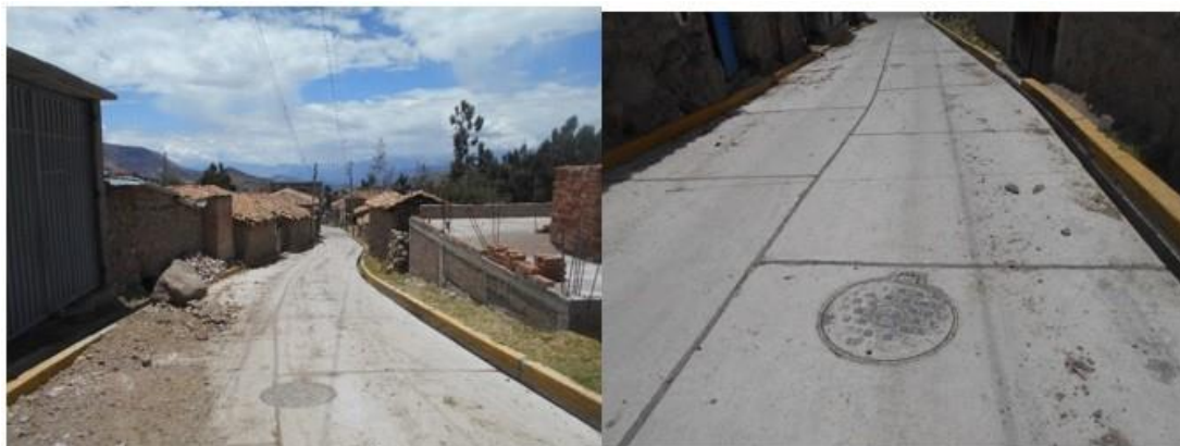
Figura 5.21: Vistas de las calles asfaltadas de la capital Socos donde la línea de distribución de agua es nueva.
