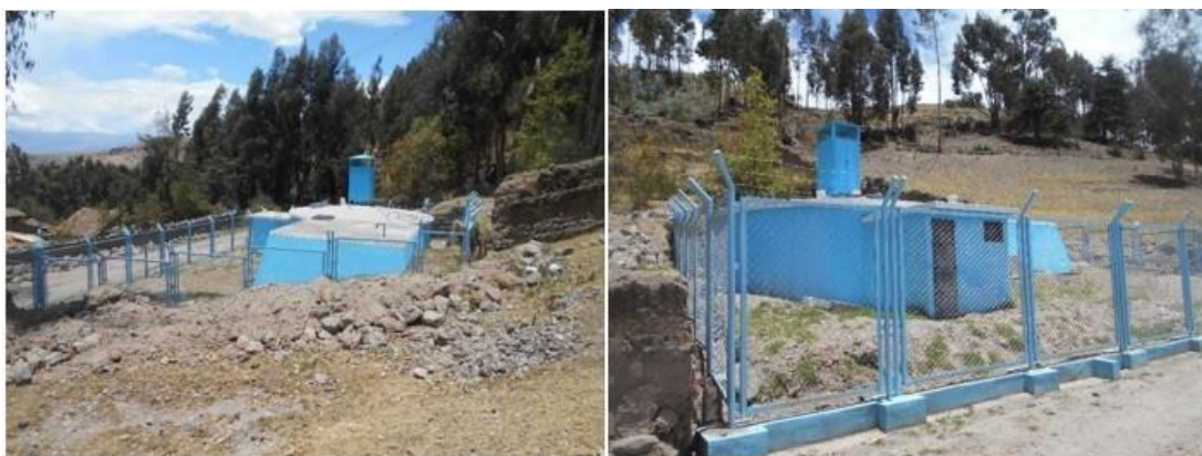
Figura 5.18: Vista del reservorio en adecuadas condiciones.
