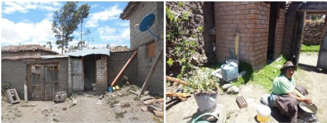
Figura 5.27: Vista del estado de las letrinas. Fuente: (Municipalidad Distrital de Socos, 2019).
