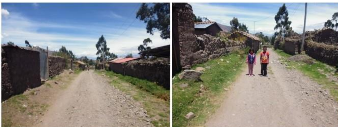
Figura 5.25: Vistas de las calles de tierras donde se encuentran las líneas colectoras. Fuente: (Municipalidad Distrital de Socos, 2019).
