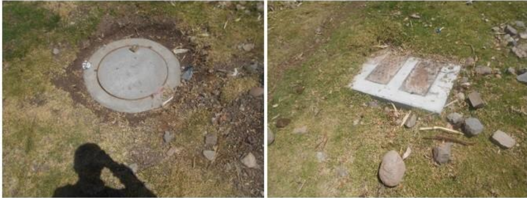
Figura 5.7: Vistas de buzones recientes en las calles sin asfaltar.
