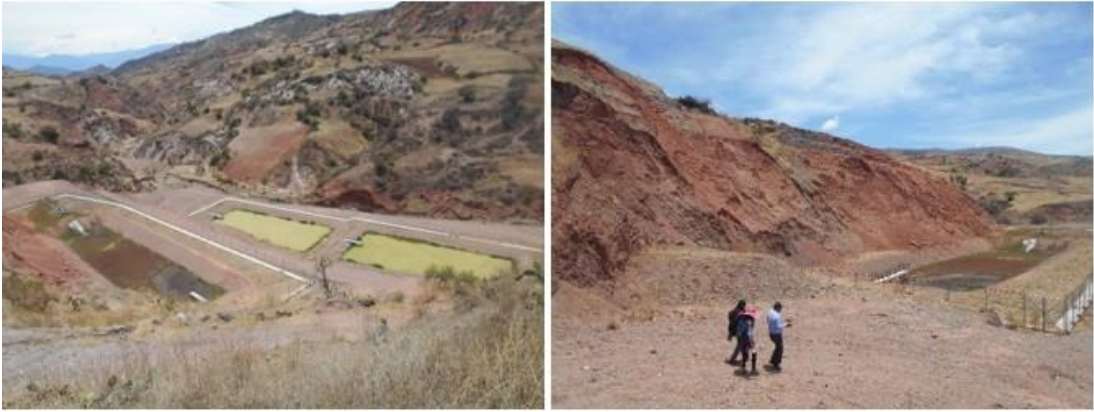
Figura 5.30: Vista de la planta de tres lagunas. Fuente: (Municipalidad Distrital de Socos, 2019).
