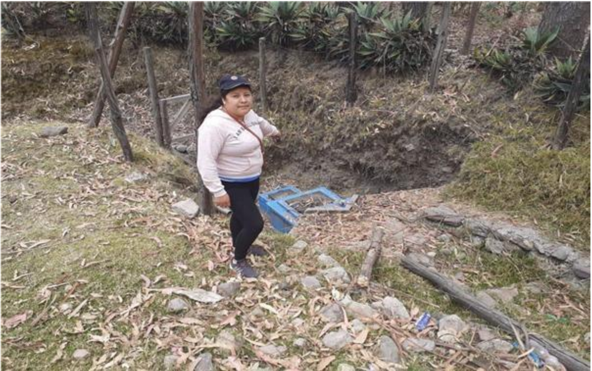
Fotografía 04: Vista lateral de la Captación.
