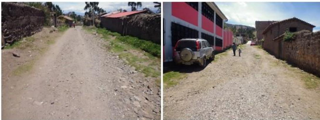
Figura 5.23: Vistas de las calles de tierras donde se encuentran las líneas colectoras. Fuente: (Municipalidad Distrital de Socos, 2019).
