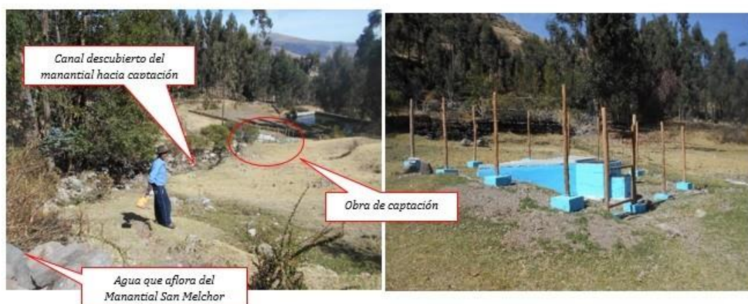
Figura 5.17: Sistema de captación actual.
