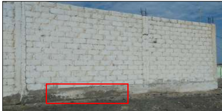
Imagen 9. Eflorescencia en Sobrecimientos - Fuente: Elaboración Propia
