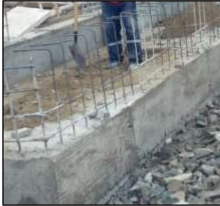
Imagen 2. Concreto Armado - Fuente: Elaboración Propia.
