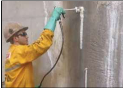
Imagen 8. Inyección para sellar Fisura – Fuente: Sika Perú. (39)
