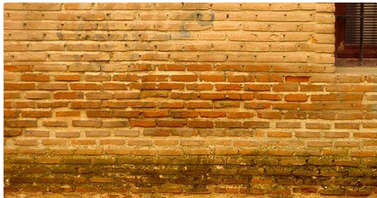
Figura 2: Humedad de Capilaridad
