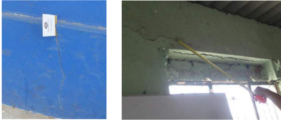
Figura 9: Asentamiento Diferencial
