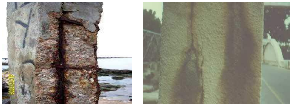
Figura 1: Corrosion
