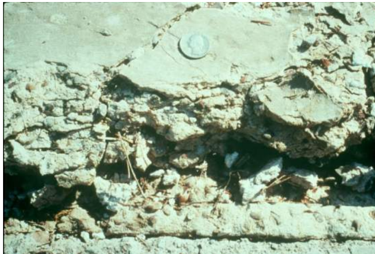
Figura 10: Desintegración
