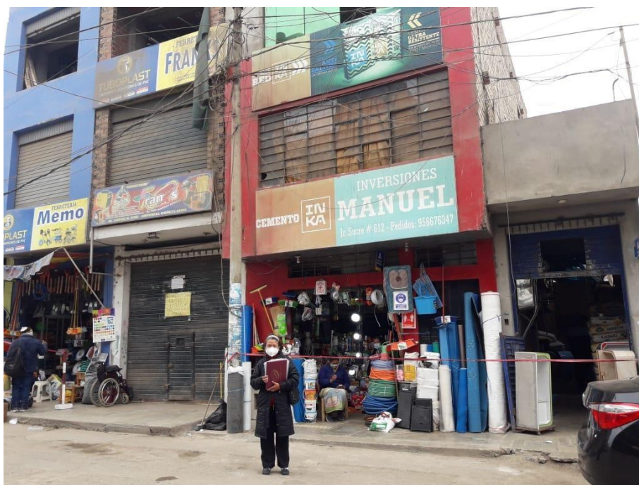
Foto 2. Ferreteria de la cuadra 7 del Jirón Sucre
