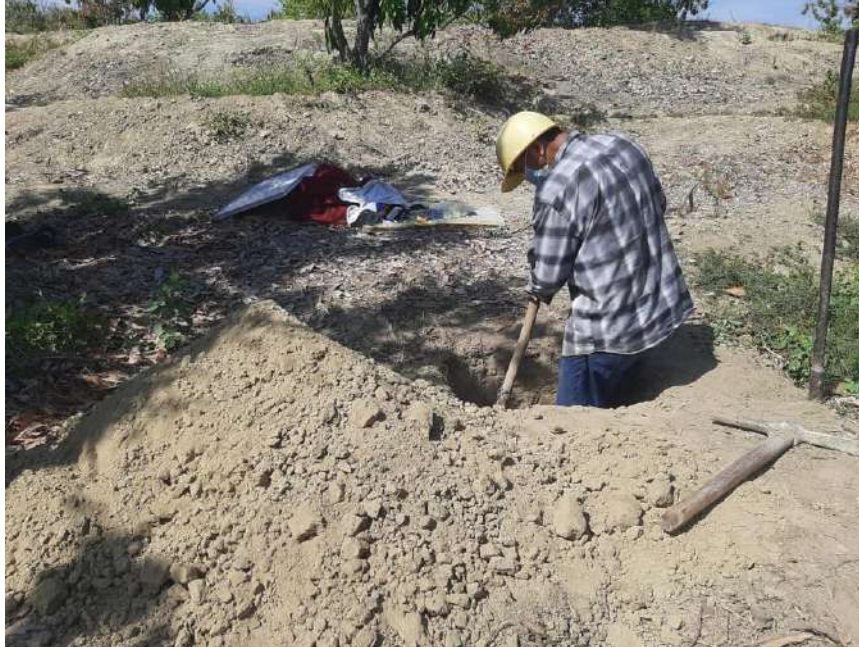
EXCAVACION DE CALICATA N° 01
