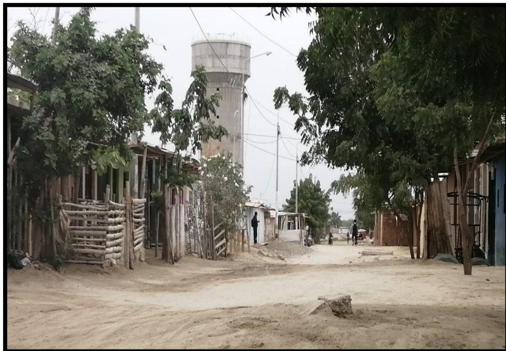
FOTOGRAFÍA 02: Ubicación del Pozo Elevado
