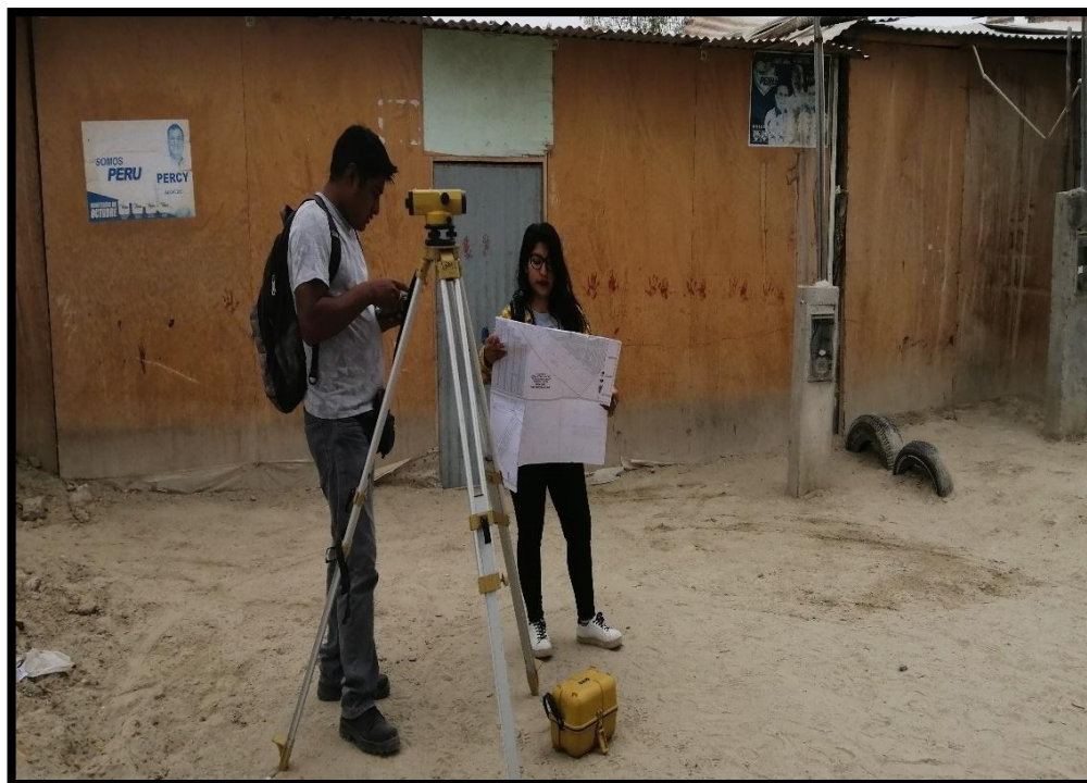
FOTOGRAFÍA 03: Verificando Zona para iniciar el levantamiento topográfico
