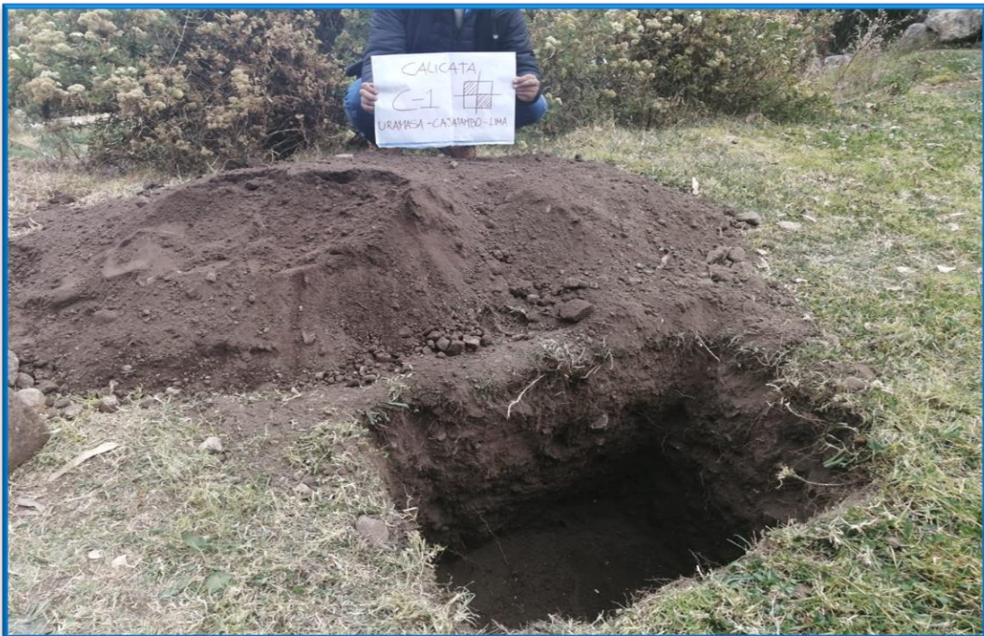
Fotografía 12: Excavación de calicatas para el estudio de suelo
