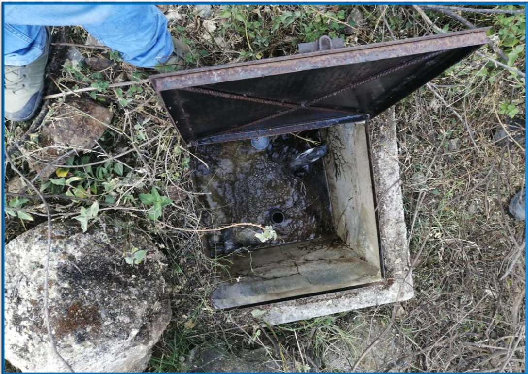
Fotografía 06: Cámara de reunión existente
