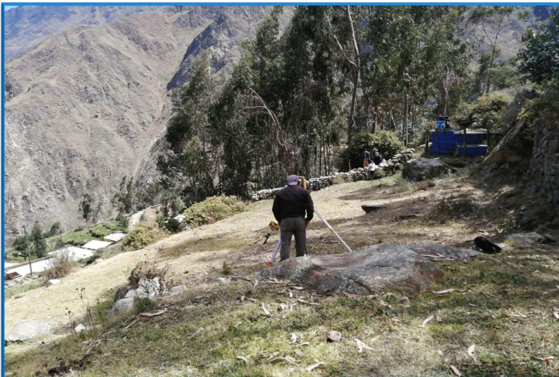
Fotografía 10: Realizando el levantamiento topográfico
