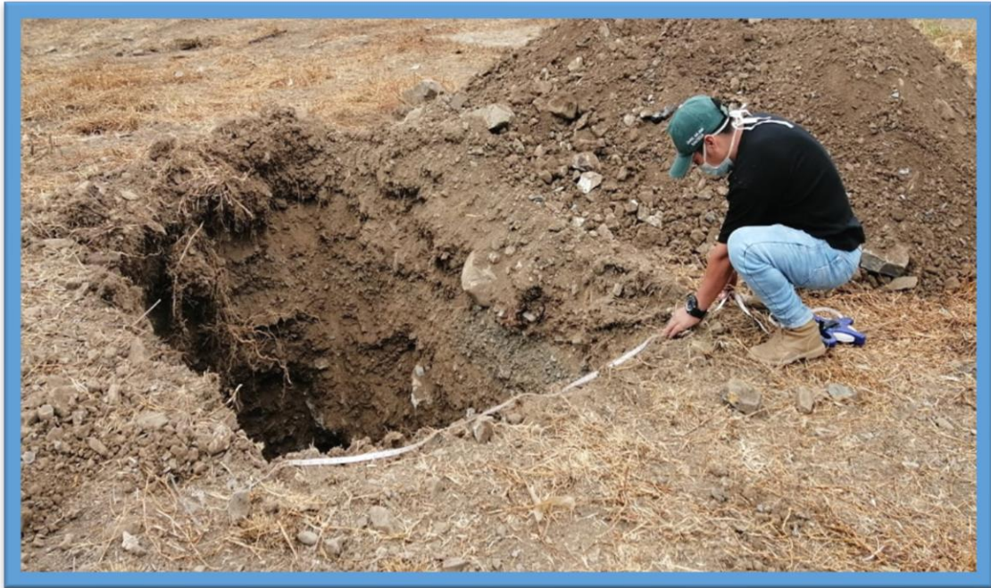
Fotografía 09: Se observa la calicata cerca del reservorio existente.
