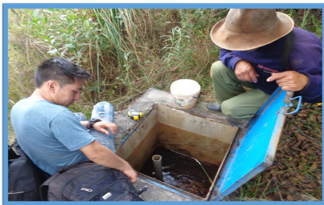
Fotografía 02: Inspeccionando el funcionamiento de la cámara rompe presión número 1 de tipo 6.
