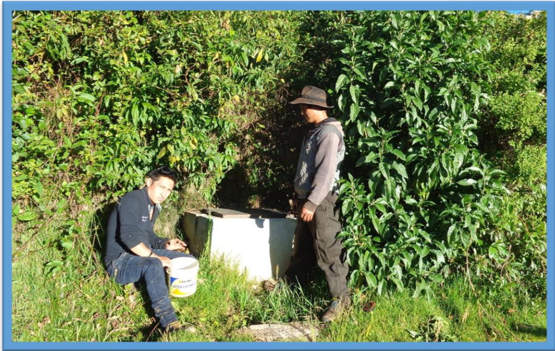
Fotografía 03: Inspeccionando el funcionamiento de la cámara rompe presión número 02 de tipo 6.
