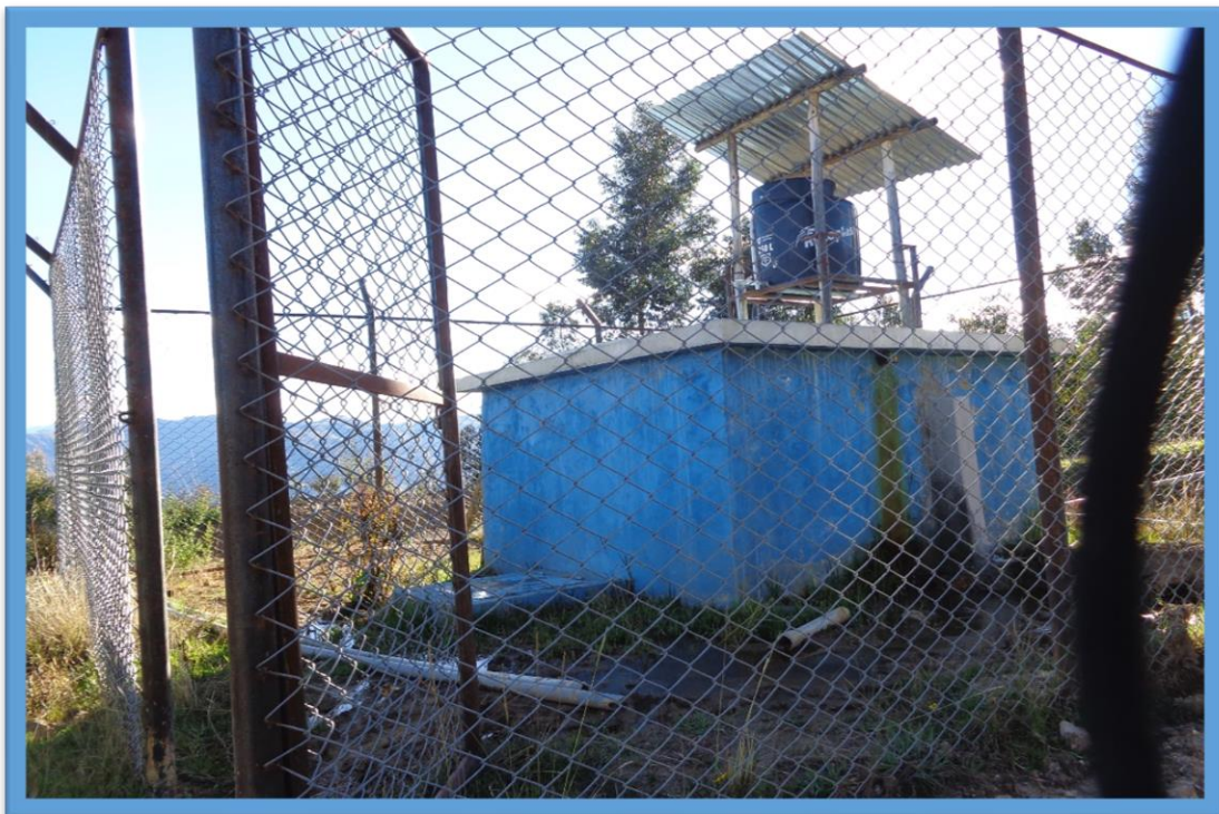
Fotografía 06: Se aprecia el cerco perimétrico del reservorio.
