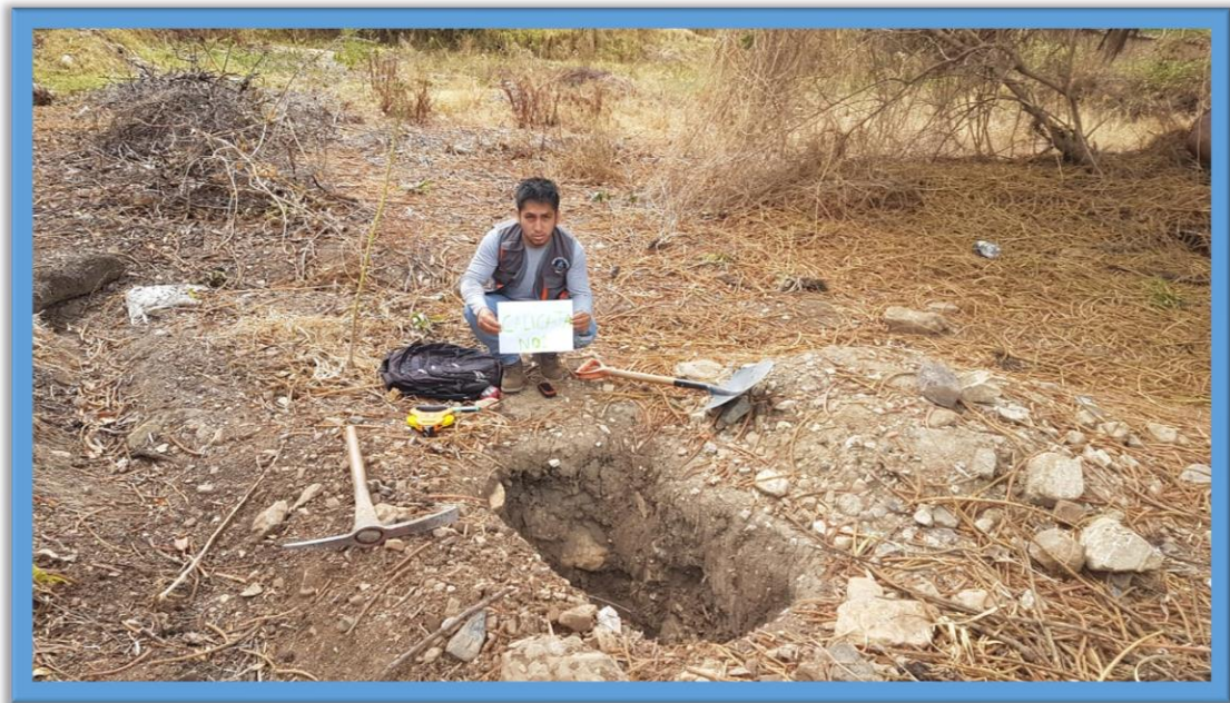
Fotografía 08: Se observa la calicata en la línea de conducción.
