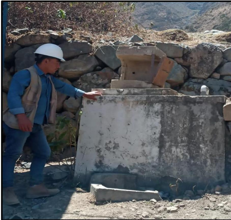
**Imagen 12.** Cámara rompe presión tipo 06 del caserío de Chunya Ruri.
