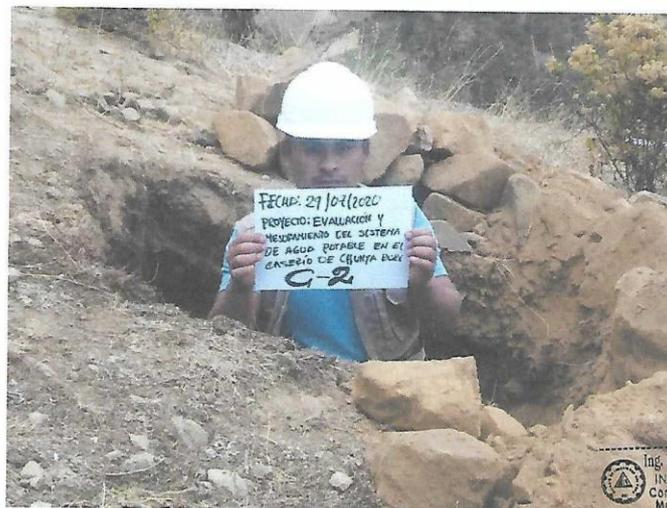
Fotografía N° 04: se puede observar la excavación y rotulado de la calicata N° 02 por donde pasara la línea de conducción.
