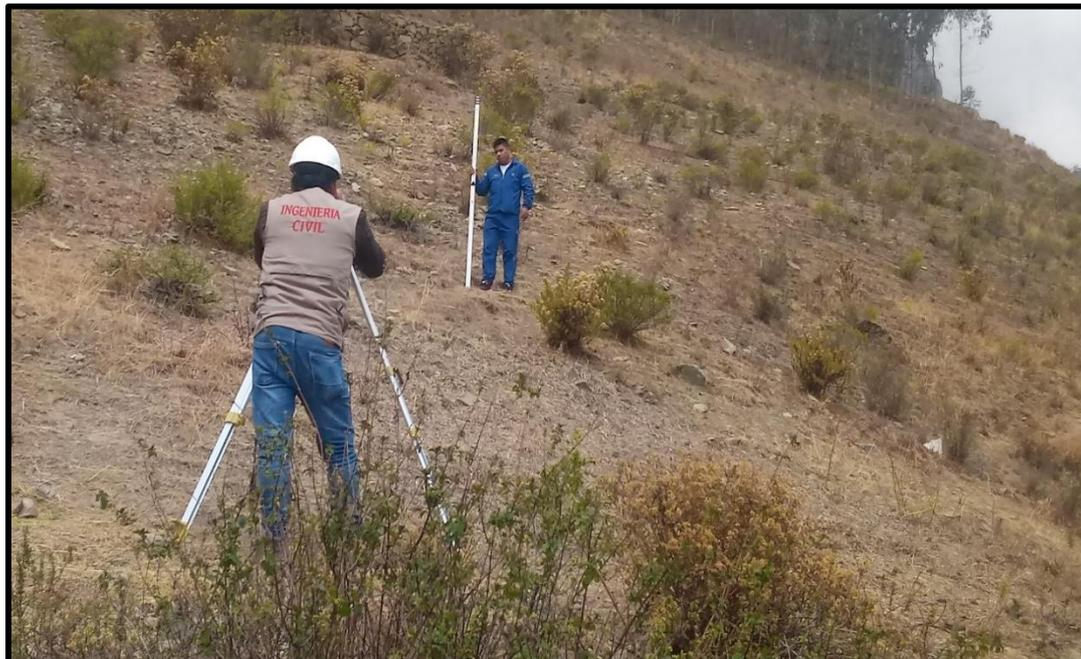
**Imagen 13.** Levantamiento topográfico del sistema de abastecimiento de agua potable del caserío de Chunya Ruri.
