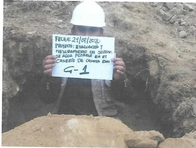
Fotografía N° 03: se puede observar la excavación y el rotulado respectivos de la calicata N° 01, donde se proyectará un reservorio.
