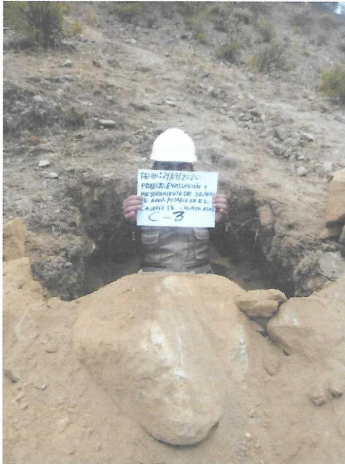
Fotografía N° 05: se puede observar la excavación y rotulado de la calicata N° 03 por donde pasara la línea de distribución.
