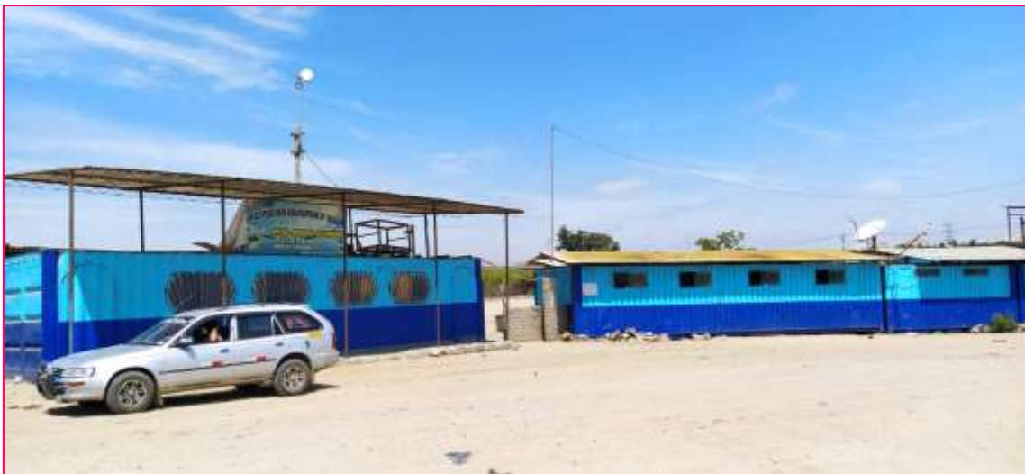
Imagen 28: Se observa 3 container que forman parte de la I.E 88407.
