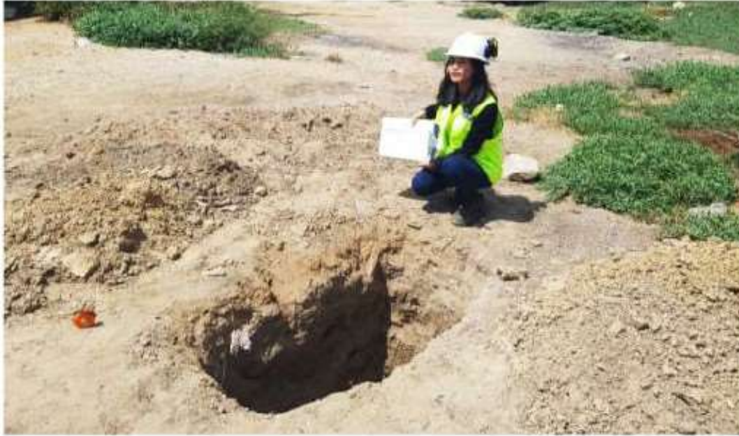
Calicata 03 – Línea de Conducción
