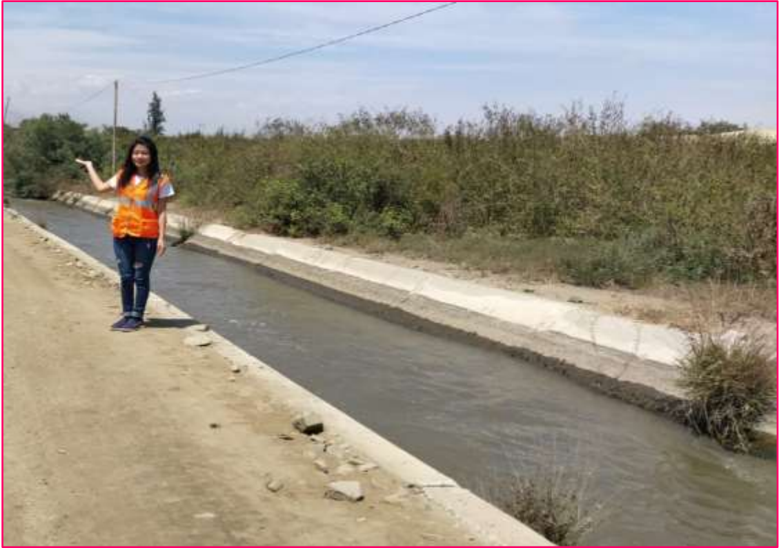
Imagen 05: Punto de captación
