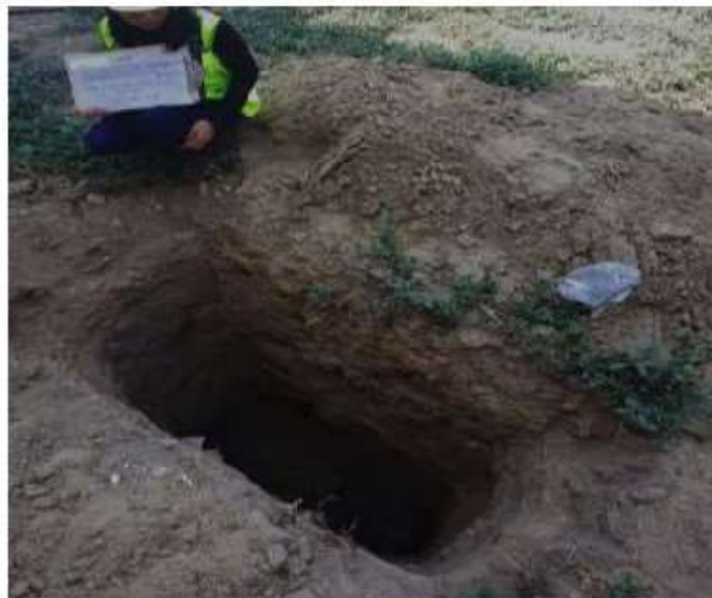
Calicata 02 – Planta de tratamiento
