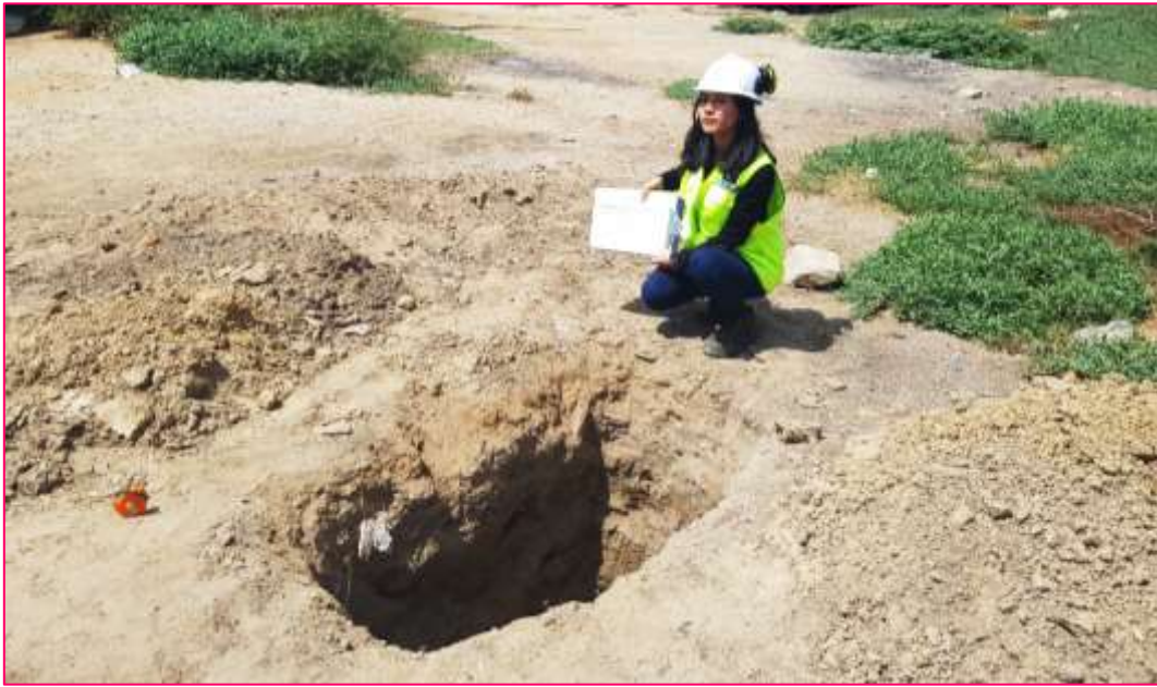
Imagen 19: Calicata en línea de conducción
