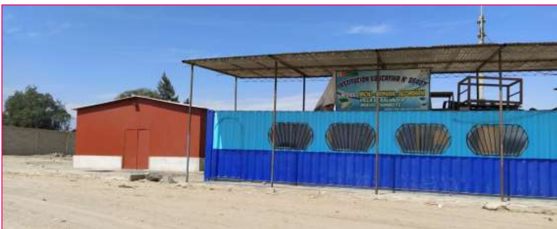
Imagen 29: A la izquierda se observa la posta médica que no funciona (un ambiente de triplay); a la derecha se puede apreciar un container perteneciente a la I.E 88407.
