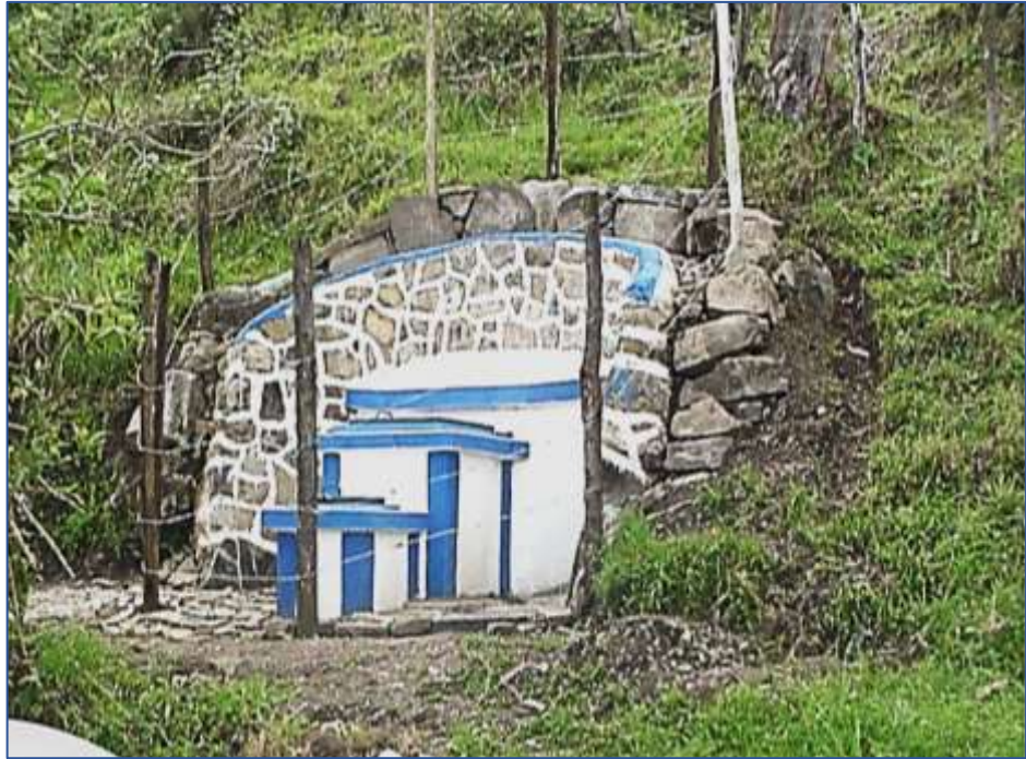
Gráfico 13: Captación tipo manantial de ladera
