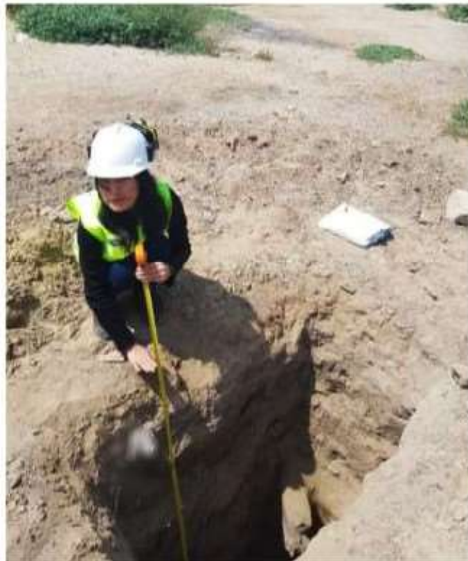
Calicata 04 – Línea de conducción
