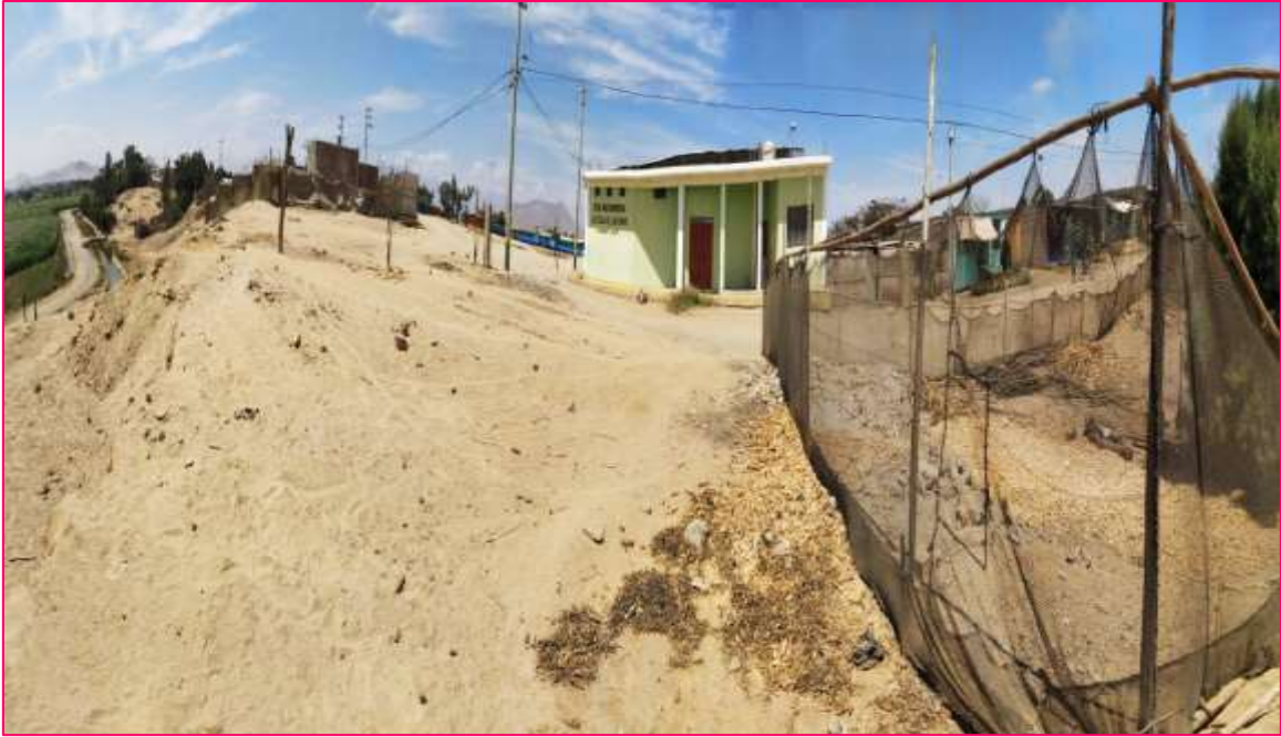
Imagen 23: Vista panorámica del local comunal
