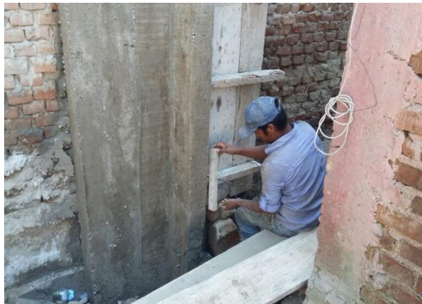
Gráfico 6: Columnas de confinamiento.
