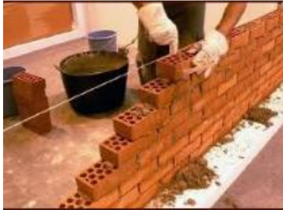
Gráfico 2: Nivelación horizontal en muros de albañilería confinada.
