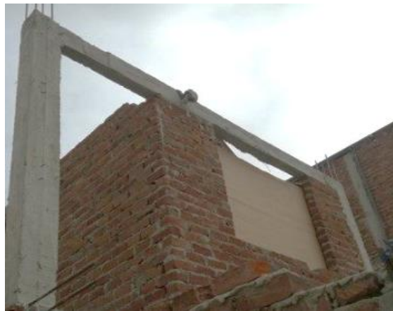
Gráfico 7: Viga de confinamiento.
