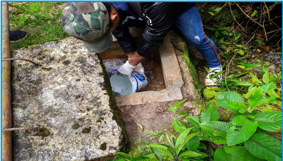
Imagen 12. Medición del caudal en la captación Quinapuquio
