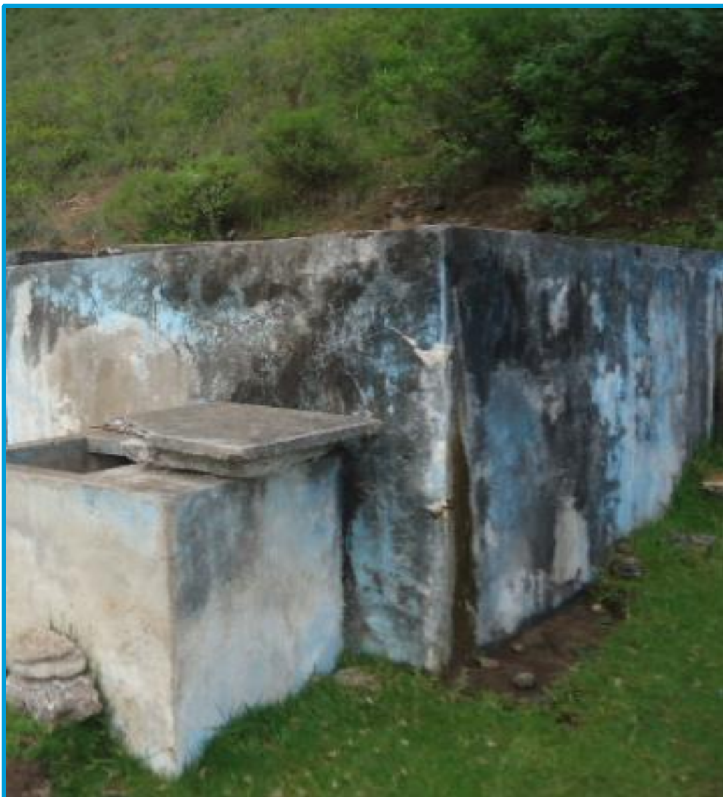
Imagen 15. Reservorio del caserío d Huashibamba
