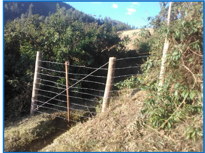
Imagen 2. Cerco perimétrico de la captación
