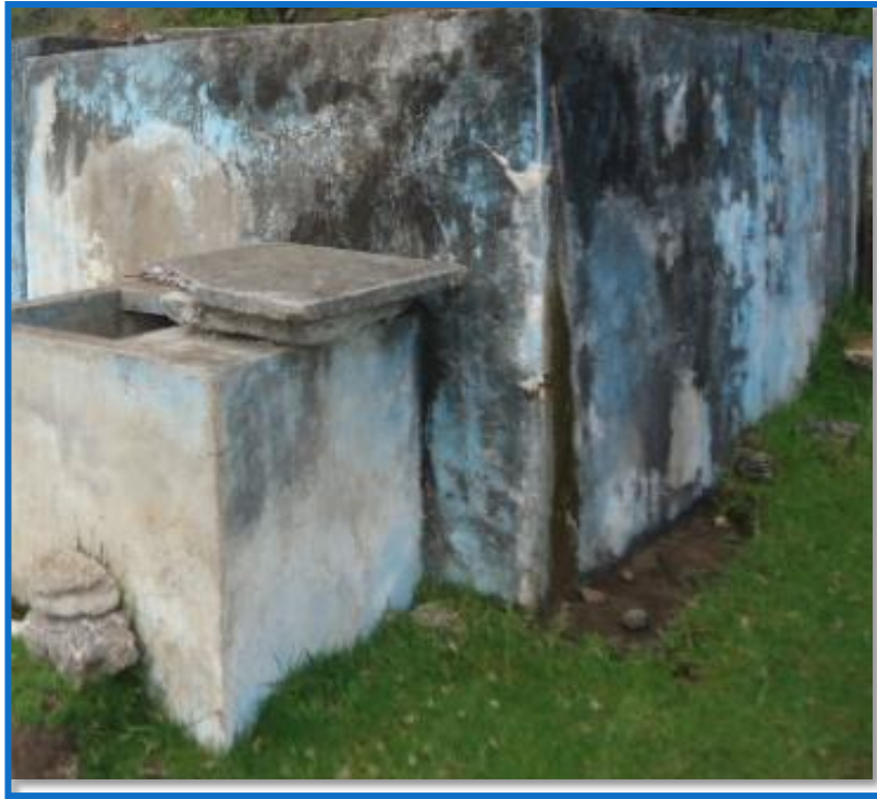
Imagen 9. Vista Frontal reservorio apoyado rectangular
