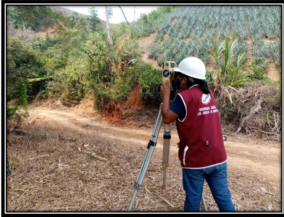
Figura 135: Vista panorámica donde se observa Realizando el levantamiento topográfico.
