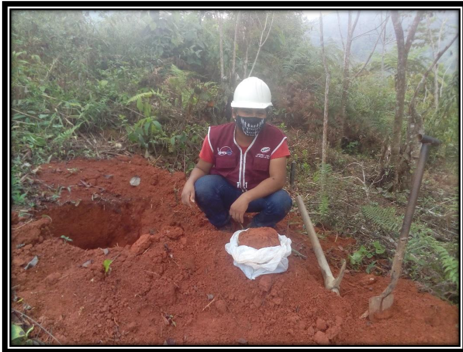
Figura 134: Vista panorámica de la calicata don se extrajo la muestra del reservorio proyectado
