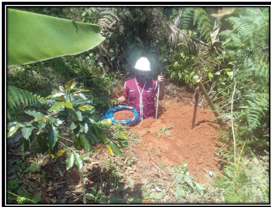
Figura 140: Extracción de la muestra para el estudio de suelos de la calicata del pase aéreo de 20 ml.
