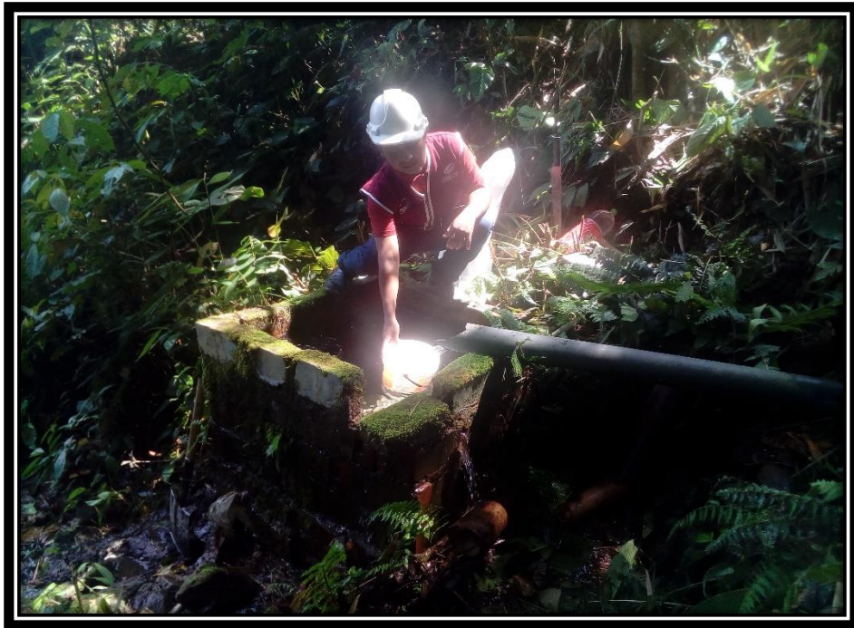
Figura 130: Realizando el aforo de la captación método volumétrico.
