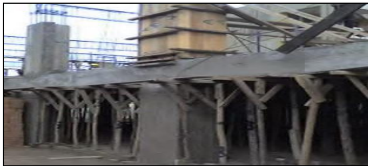
Figura 13: Vigas de concreto armado
