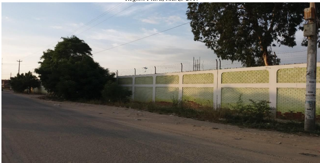
Fotografía 2: Fachada Principal del cerco perimétrico avenida Eguiguren 1049, distrito de Piura, Provincia de Piura, Región Piura, Marzo 2017
