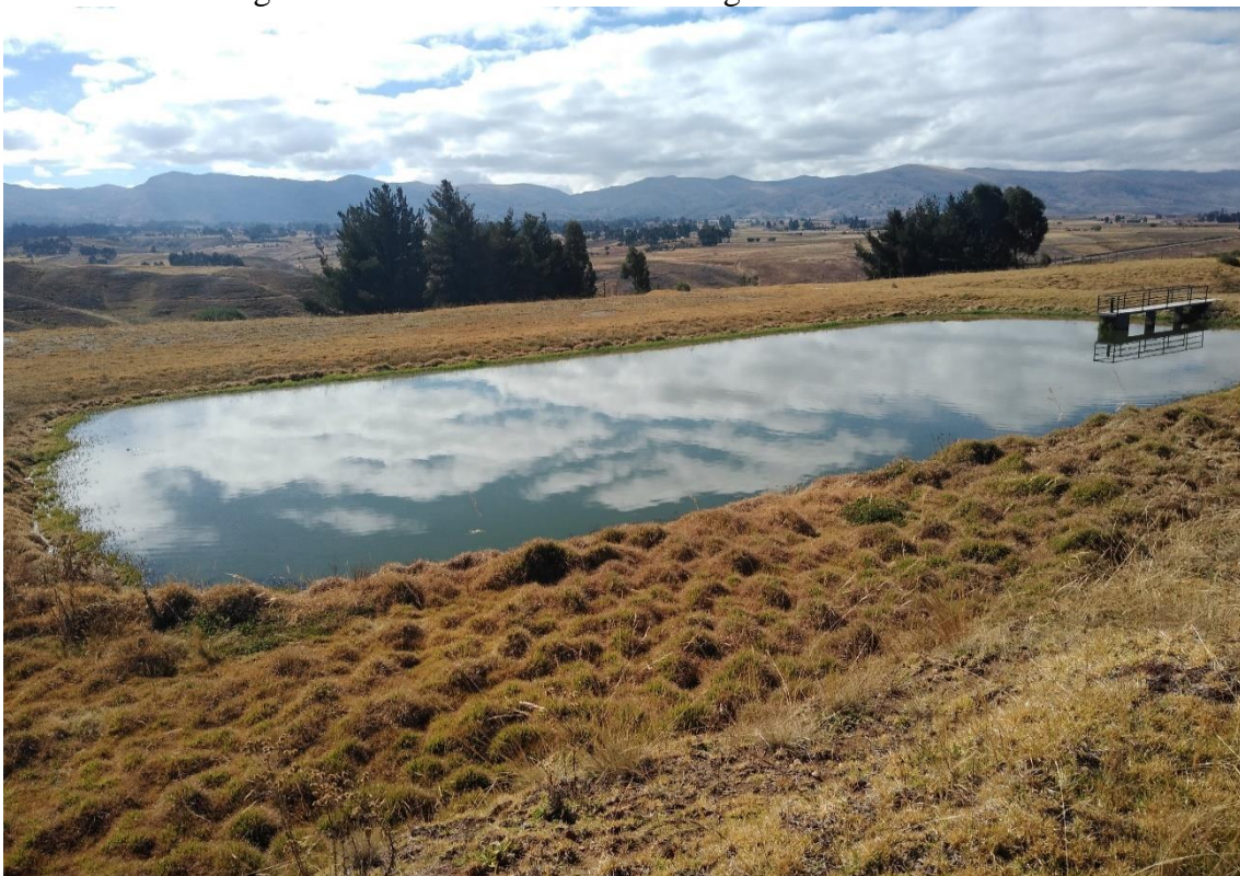
Imagen 18: Situación actual de las lagunas de estabilización.
