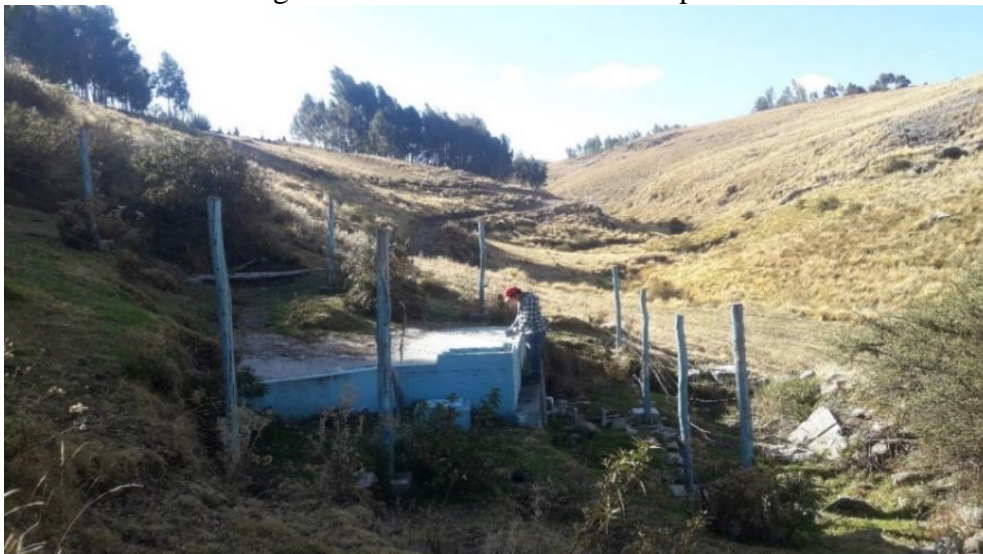
Imagen 5: Situación actual de la captación
