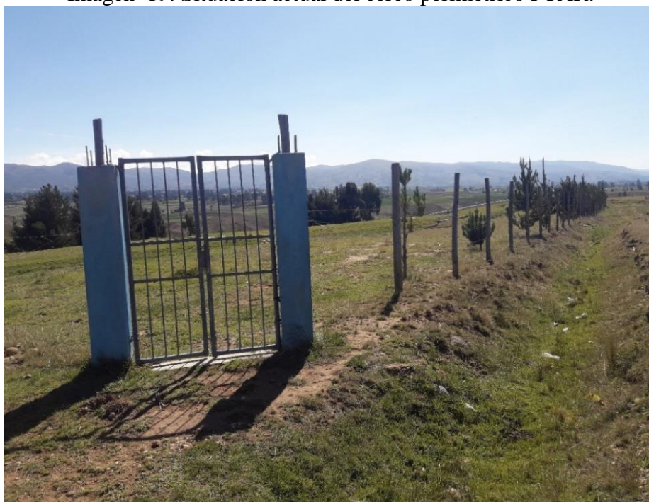
Imagen 19: Situación actual del cerco perimétrico PTAR.
