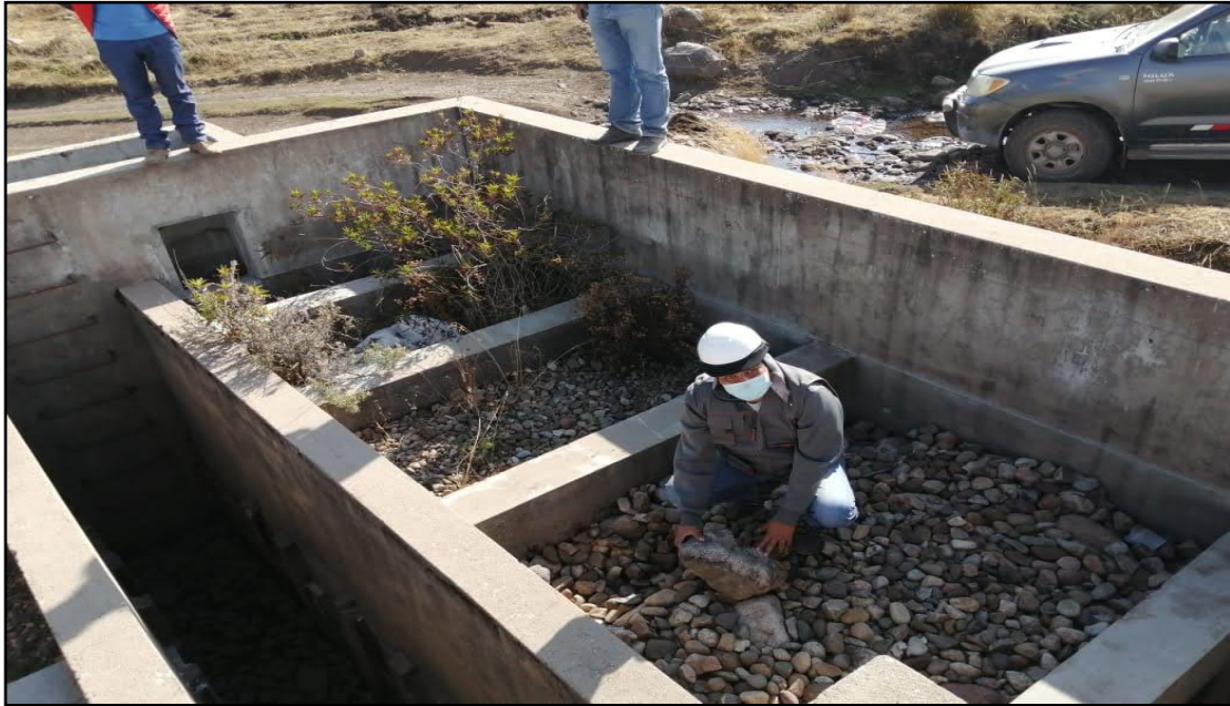
Imagen 22: Filtro lento con gravas no uniformes.
