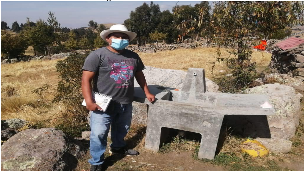
Imagen 6: Lavadero en desuso.
