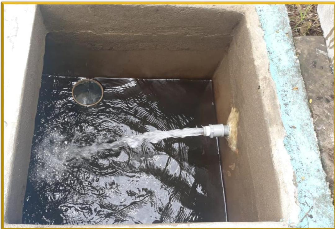
**Fotografía 13:** Se puede observar el estado de la cámara rompe presión tipo 6.
