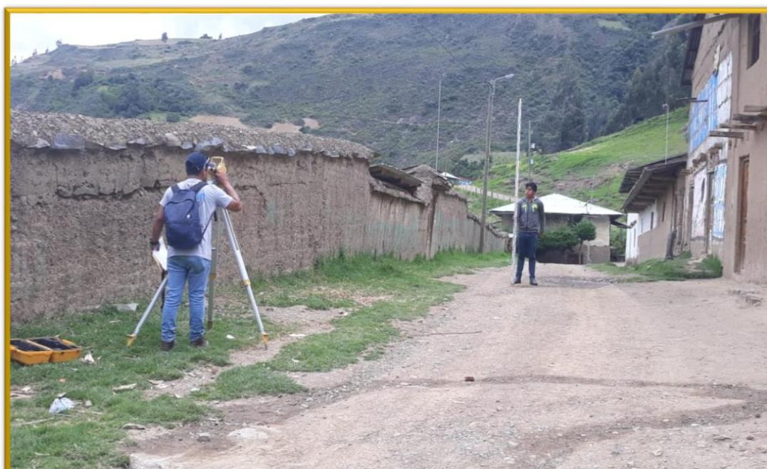
**Fotografía 05:** Levantamiento topográfico en la red de distribución.
