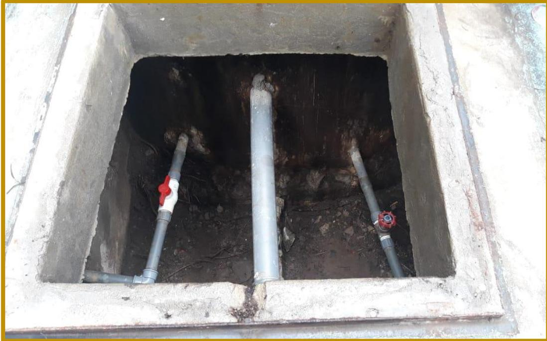
**Fotografía 16:** Cámara de válvulas del reservorio.
