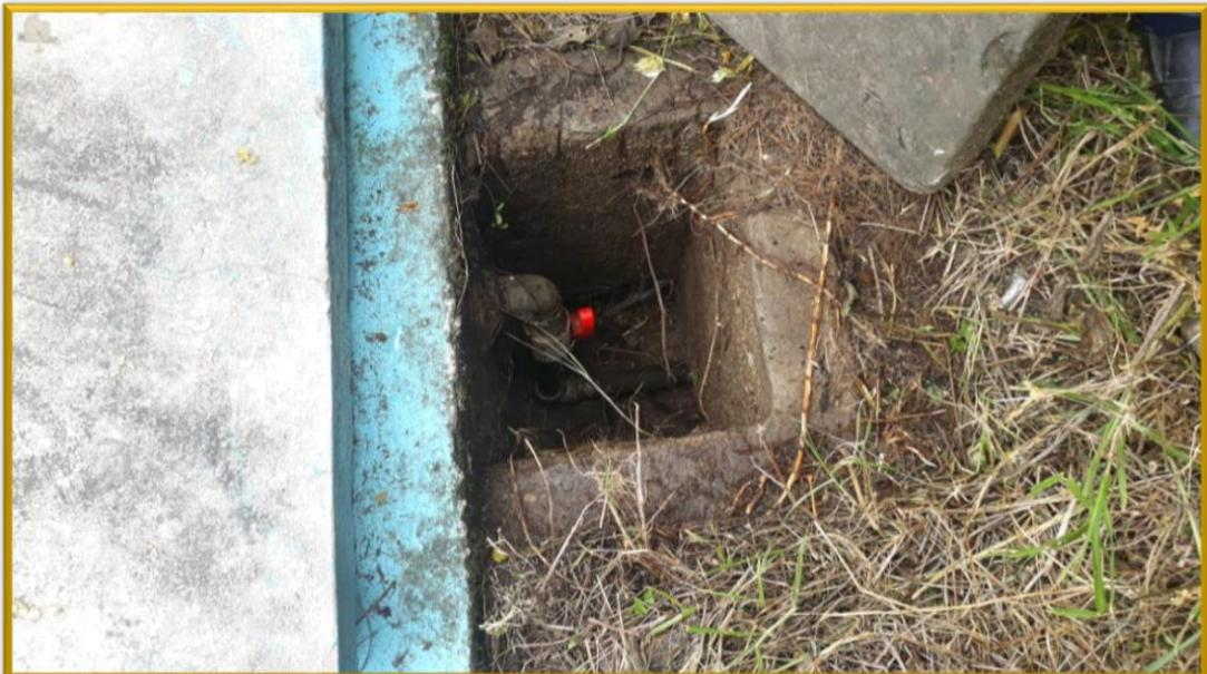
**Fotografía 18:** Válvula de control de la cámara rompe presión tipo 7.
