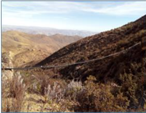
Imagen 7: Cruce aéreo sobre quebrada, de 15 ml.
