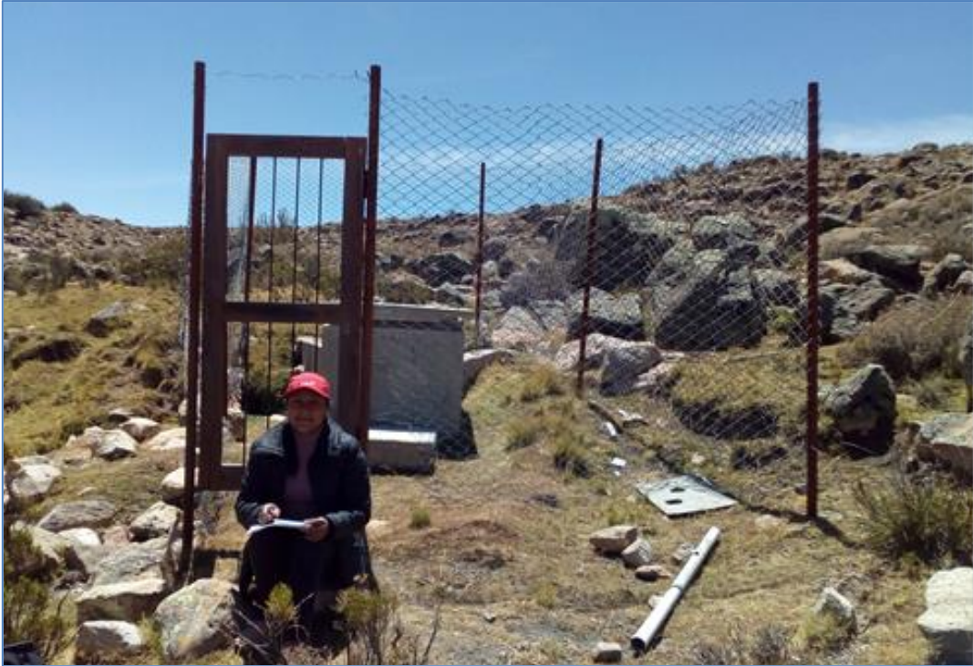
Figura 15: Cerco perimétrico de la captación Chuñuna
