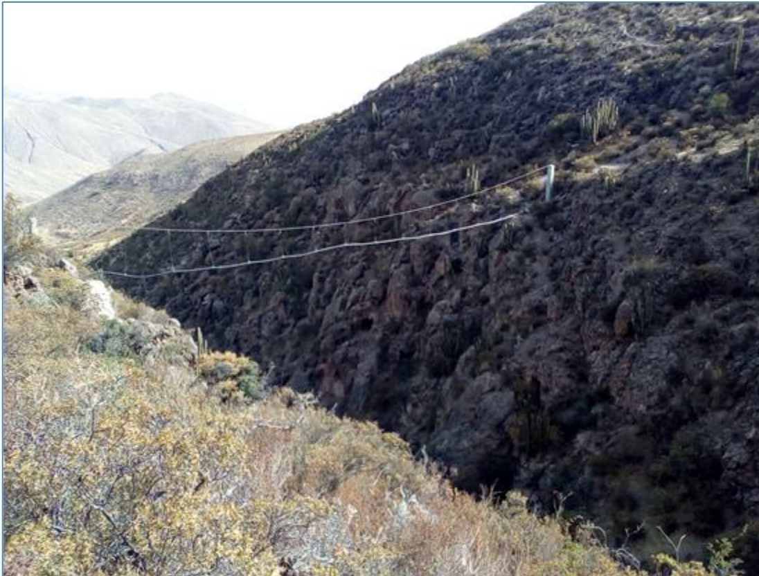
Figura 20: Cruce aéreo del sistema de agua potable
