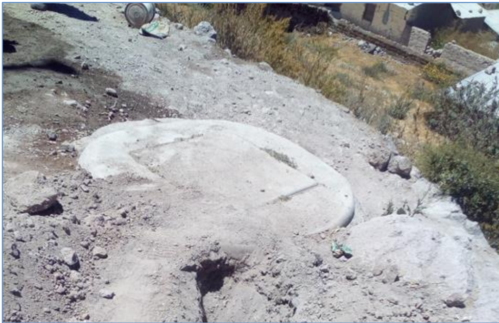
Figura 26: Buzón en red colector
