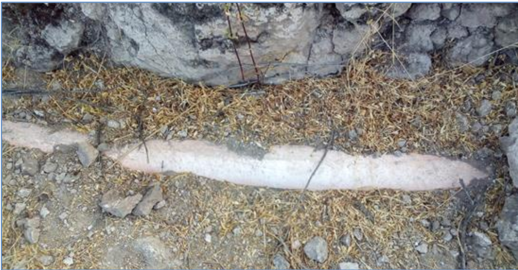
Figura 25: Tubería emisor de alcantarillado cubierta parcialmente
