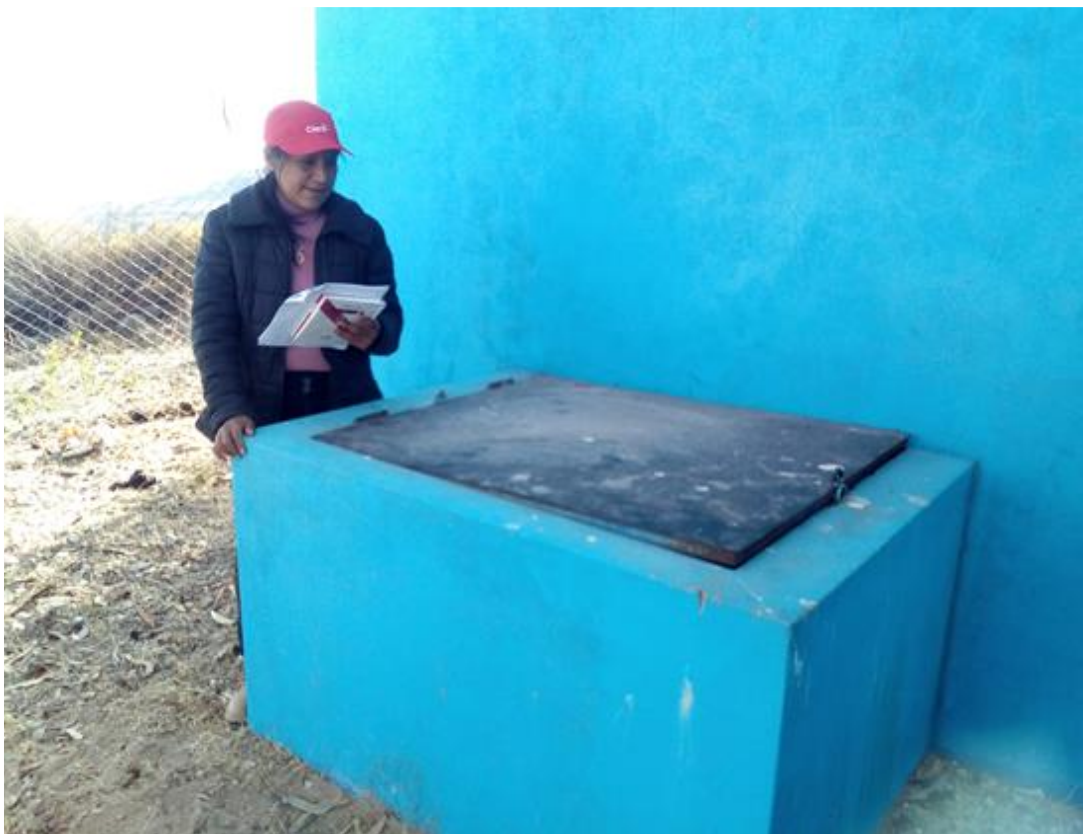
Figura 21: Evaluacion de la caja de válvula y accesorios
