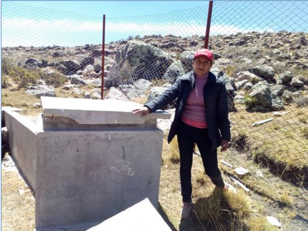
Figura 14: Estructura de captación Chuñuna
