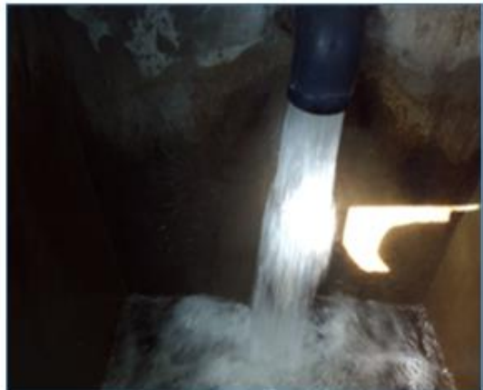
Imagen 5: Cámara Rompe Presión T-6 vista internamente.
