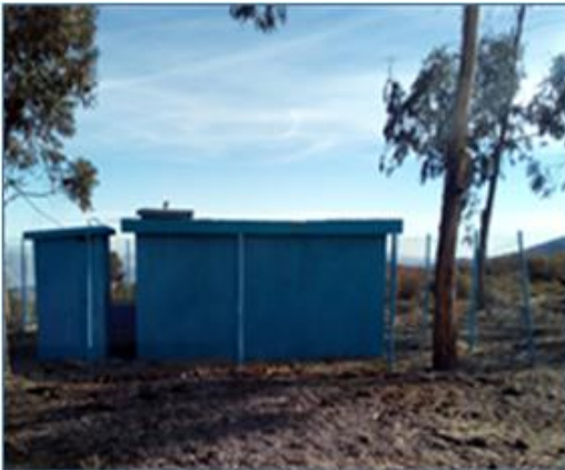
Imagen 8: Reservorio y cerco perimétrico en adecuadas condiciones.
