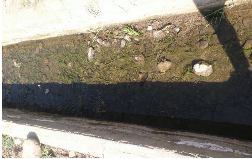
Imagen 05: Sedimento en el fondo del canal.
