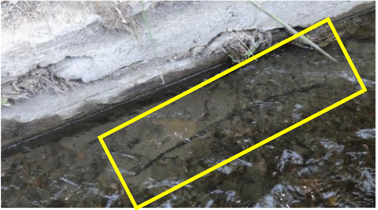
Fotografía 05: Sedimento en la unidad de muestra 4 en el canal de riego Monte Común.
