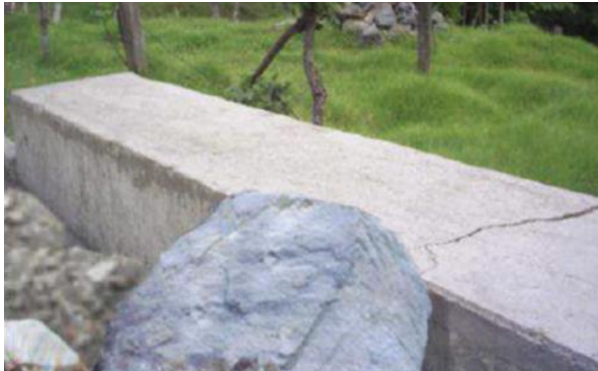
Imagen 09: Impacto en la caja del canal.
