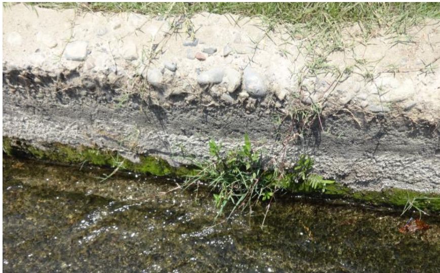
Imagen 04: Vegetación en la caja de canal.
