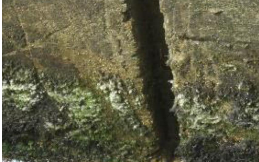
Imagen 10: Sello de junta del canal.
