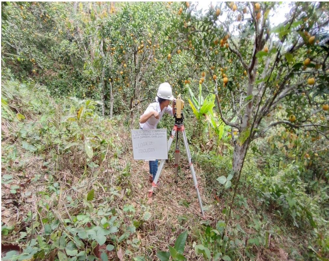
**Figura 25:** Vista levantamiento topográfico en la línea de conducción
