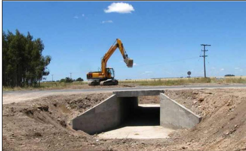
**Figura 4.** Alcantarilla hidráulica.
