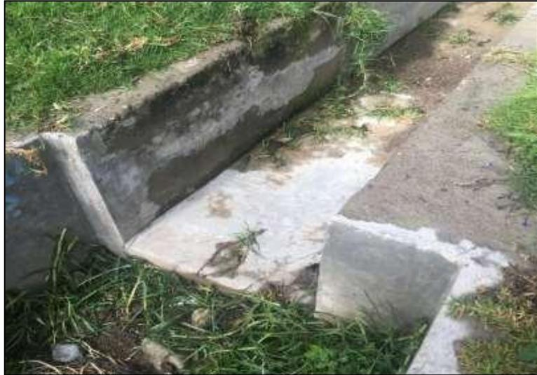
**Figura 28.** Eflorescencia en canales de riego
