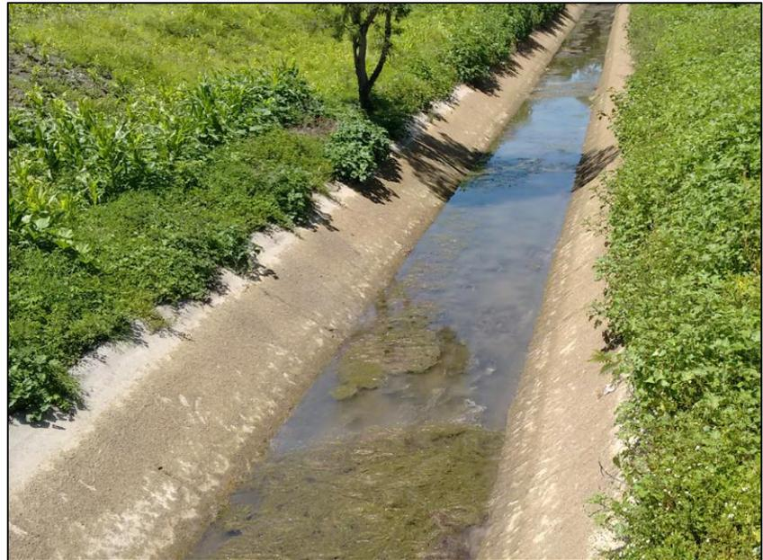
**Figura 26.** Descascaramiento en canales de riego.
