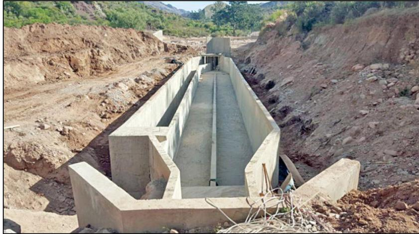
**Figura 5.** Desarenador hidráulico.
