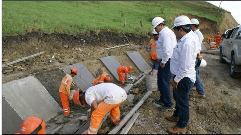
**Figura 15.** Construcción de canal de riego.
