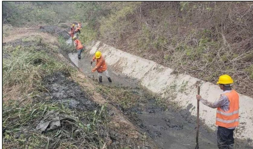
**Figura 18.** Mantenimiento de un canal de riego.
