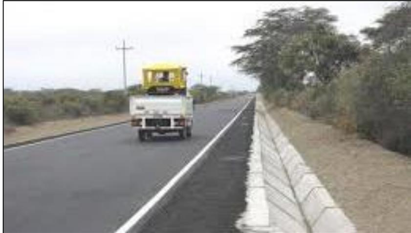
**Figura 8.** Cuneta hidráulica.
