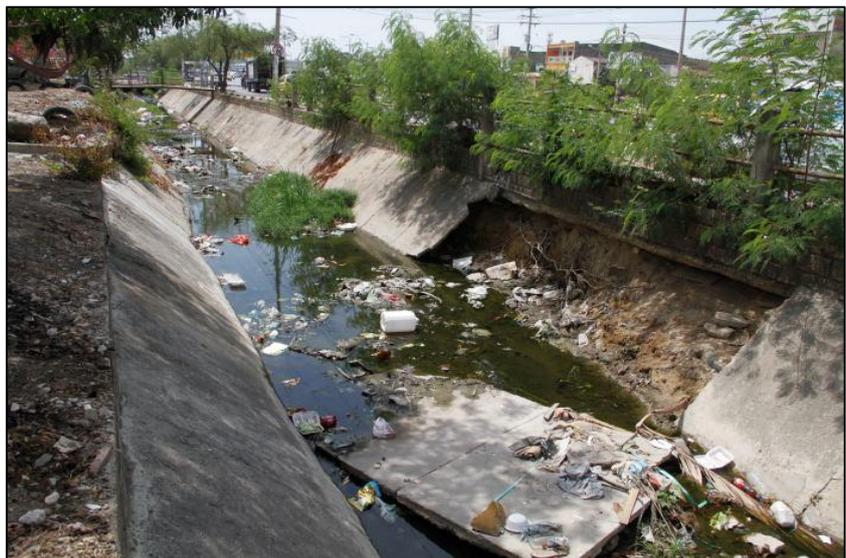
**Figura 27.** Hundimiento en canales.
