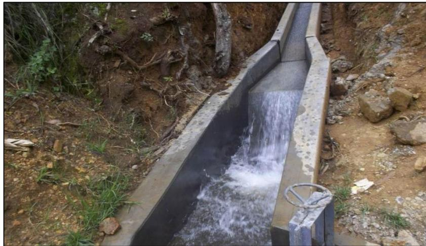
**Figura 3.** Poza disipadora de energía.
