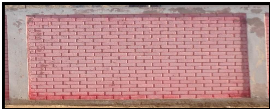
Figura 07. Imagen de Albañilería Confinada
