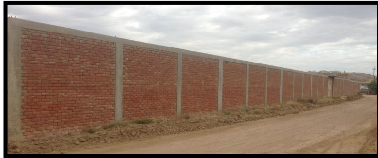
Figura 16. Imagen de Cerco Perimétrico
