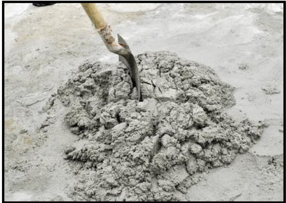
Figura 01. Imagen de Concreto
