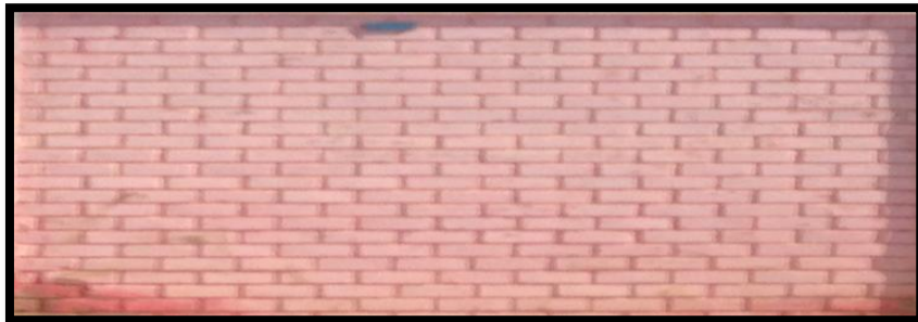
Figura 06. Imagen de Albañilería
