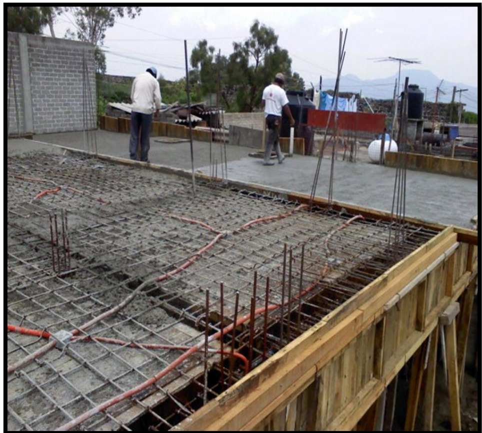
Figura 02. Imagen de Concreto Armado
