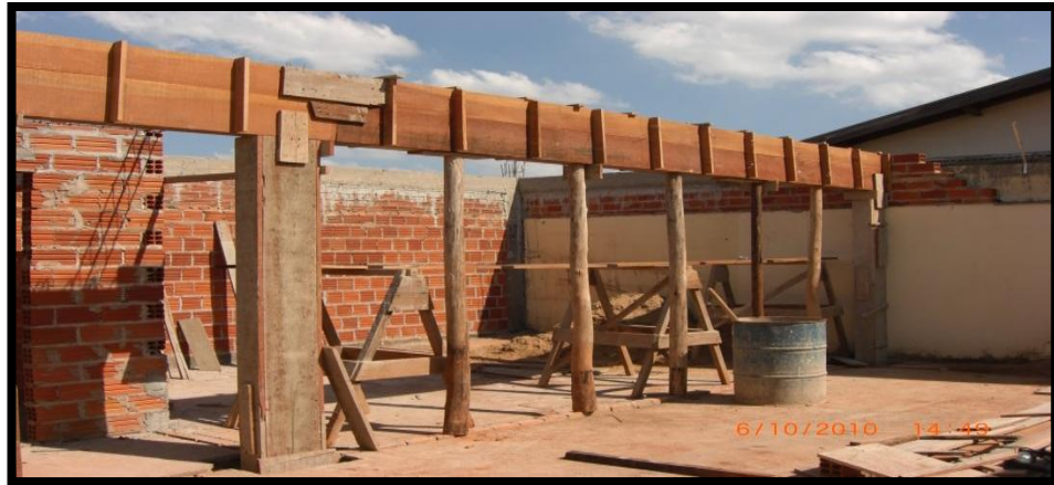
Figura 04. Imagen de Vigas de Concreto
