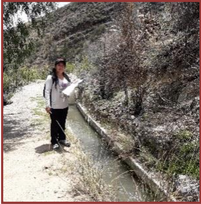
Fotografía N° 03: Recorrido del canal para el registro de las patologías identificadas.
