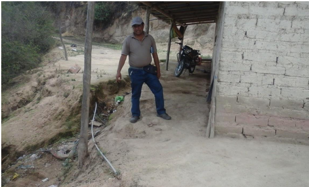
Evaluación de Tubería en Domicilio.
