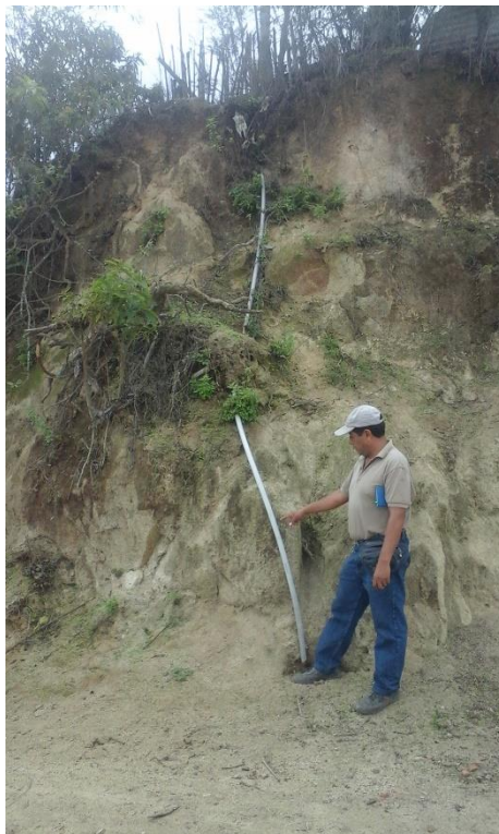
Evaluación de Tubería Expuesta.
