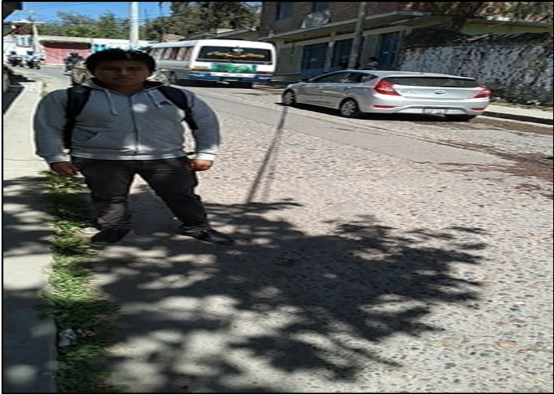
Fotografía 5: Parche grande, pulimiento de agregados presente en la cuadra 03 de la Avenida Carmen Alto.
