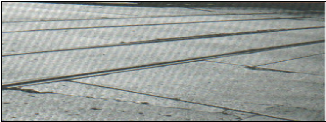
Figura 2.20: Cruce de vía Férrea.
