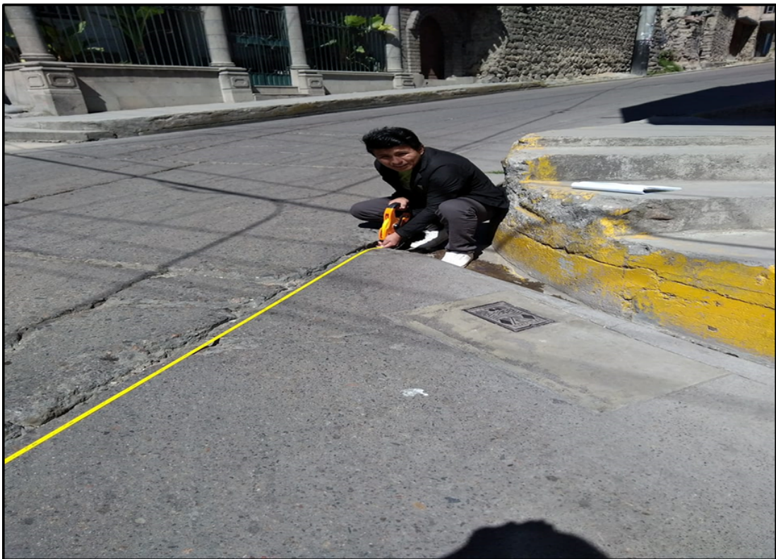
Fotografía 2: Medición de la losa de la Avenida Carmen Alto.
