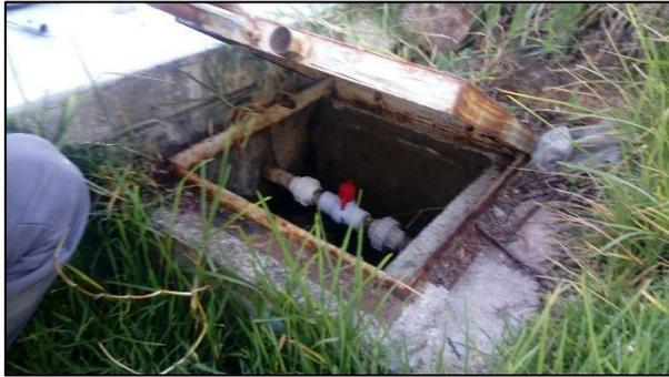
*Ilustración 14.* Válvula de cámara rompe presión tipo 7
