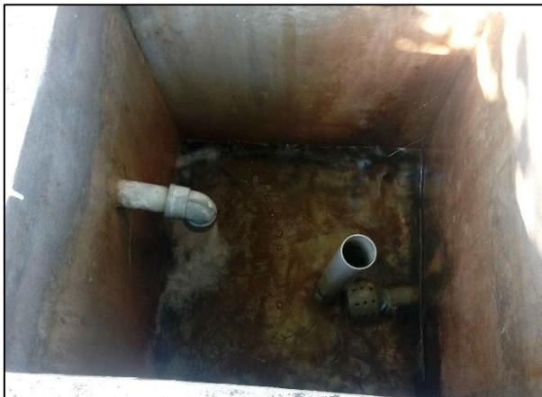
*Ilustración 13.* Cámara húmeda del CRP 6 (N° 01)
