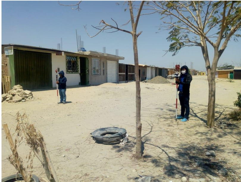
Figura 5. Levantamiento topográfico en calles del A.H Nuevo Amanecer con Jesús.
