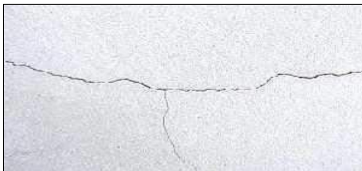
Grafico N° 03: Fisura extendida Fuente: elaboración propia.
