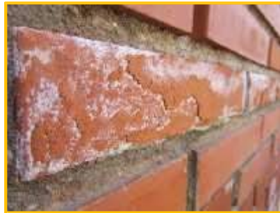
Gráfico N° 05: Presencia de criptoflorescencias Fuente: Elaboración propia.
