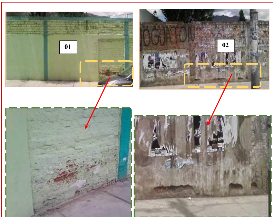
Gráfico N° 179: Patología – Erosión (UM – 27, UM - 22)
