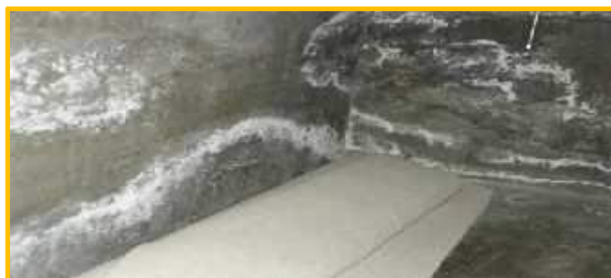
Gráfico N° 04: Presencia de eflorescencia Fuente: Elaboración propia.
