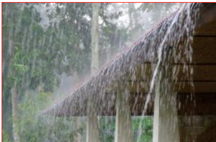
Imagen 05: Sistema de captación de agua pluvial
