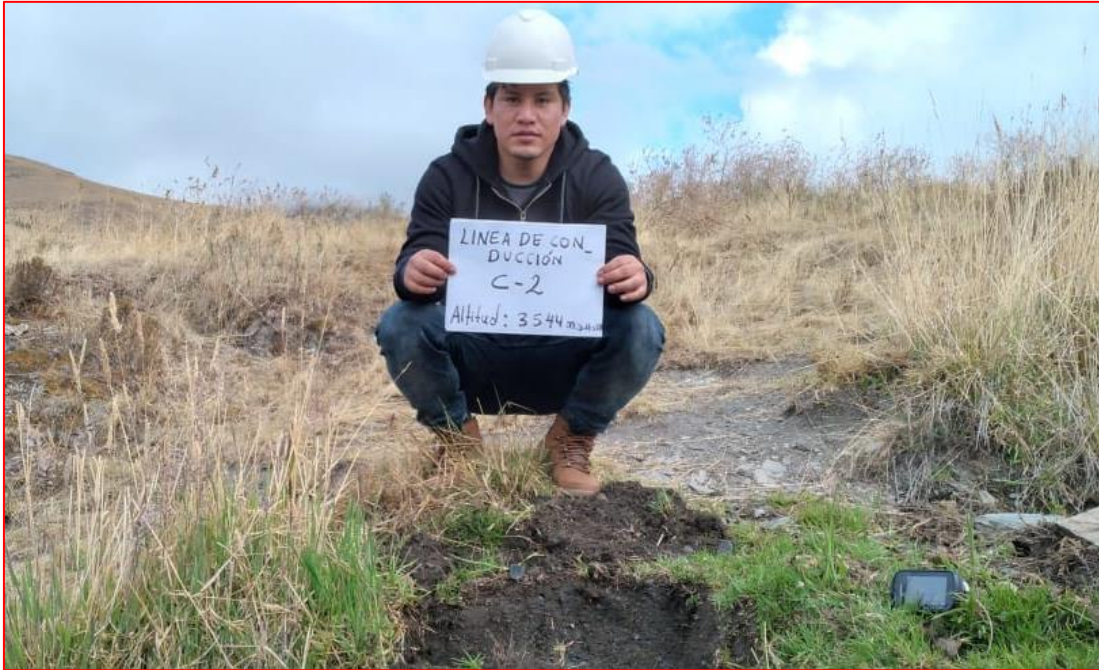
Imagen 33: Excavación de Calicata – línea de conducción
