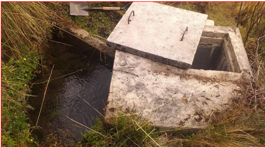
Imagen 24: Se aprecia la captación existente en el centro poblado de Cualuto.
