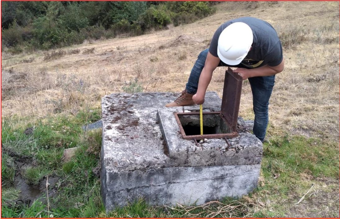
Imagen 31: Inspeccionando Cámara Rompe Presión tipo 6.
