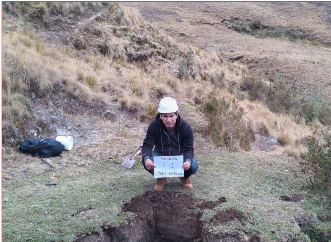
Imagen 32: Excavación de Calicata - captación
