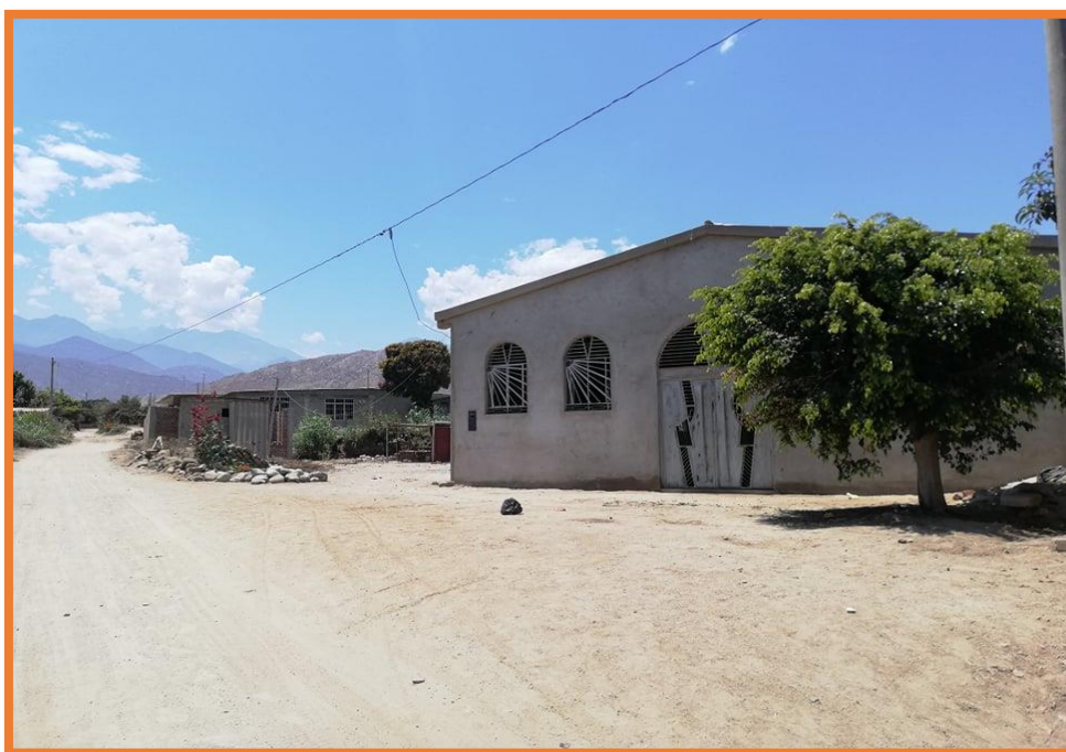
Imagen 10. Iglesia del caserío de Quillhuay, distrito de Moro, provincia del Santa, región Áncash
