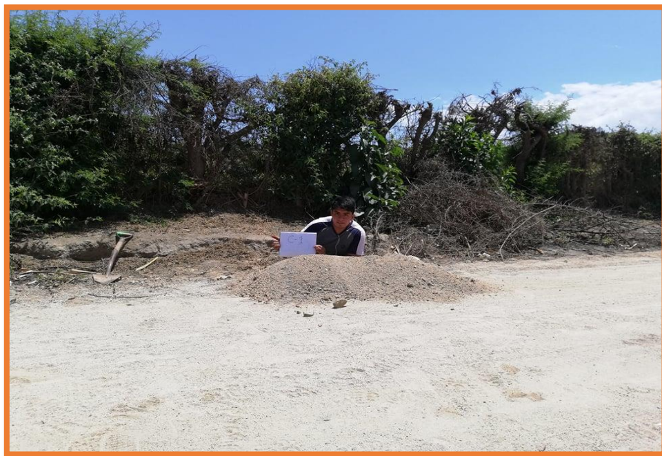
Imagen 12. Elaboración de calicata (c-1), en el área destinada de la red.
