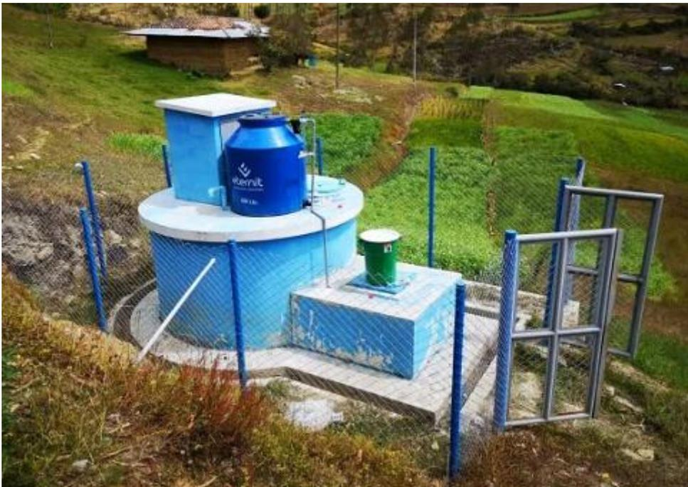
**Figura 11** Sistema de desinfección y reservorio
