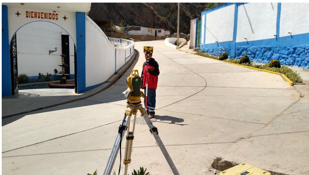
Fotografía 20: Levantamiento topográfica línea de aducción
