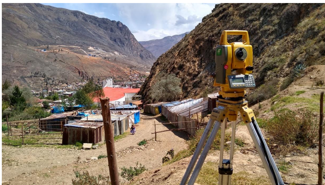
Fotografía 8: Levantamiento Línea de Conducción – Ubicación propuesta de reservorio
