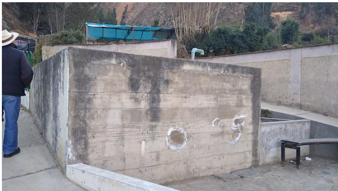
Fotografía 17: Reservorio de 16 m 3 existente
