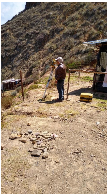
Fotografía 21: Levantamiento topográfico línea de conducción
