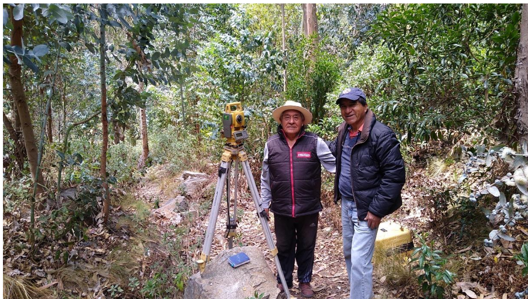
Fotografía 7: Levantamiento Línea de Conducción, se observa Presidente y fiscal de la JASS CP Muruhuay
