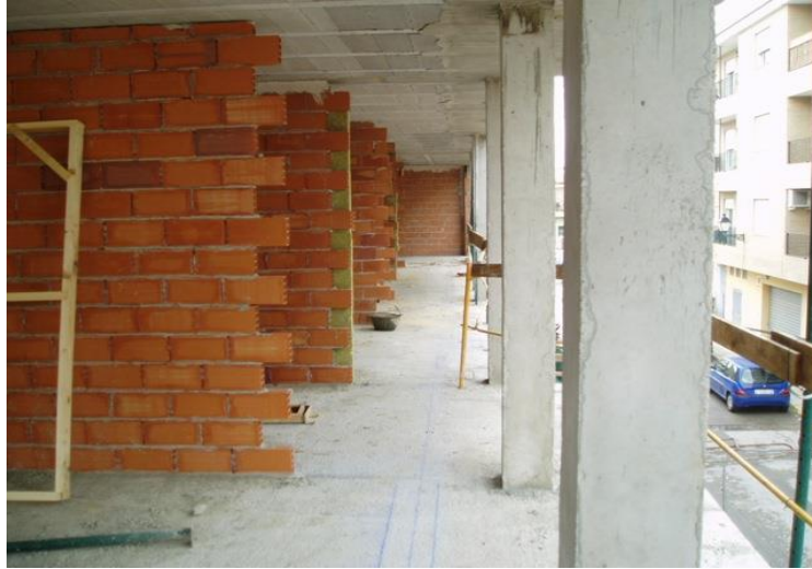
Figura 13. Muros no portantes (Mayer M. 2014) 11
