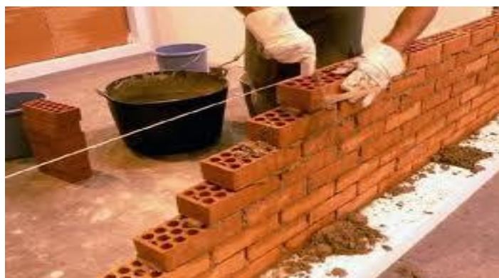
Figura 14. Albañilería simple Nota. Fuente: (Guipúzcoa I. 2011) 12
