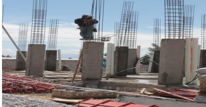
Figura 21. Comunas de confinamiento Nota. Fuente: (Abanto F. 2007) 14
