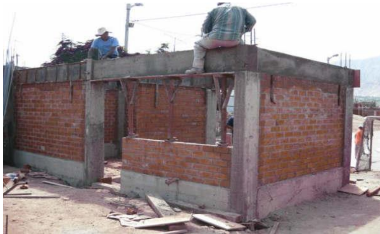
Figura 18. Albañileta Confinada Nota. Fuente: (Guipúzcoa I. 2011) 12
