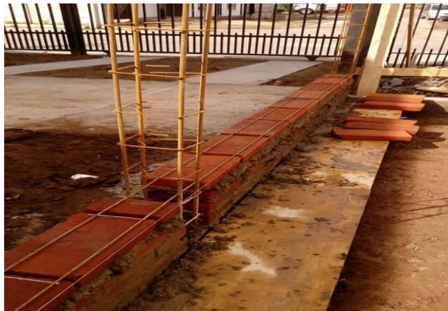
Figura 15. Albañilería armada Nota. Fuente: (Guipúzcoa I. 2011) 12
