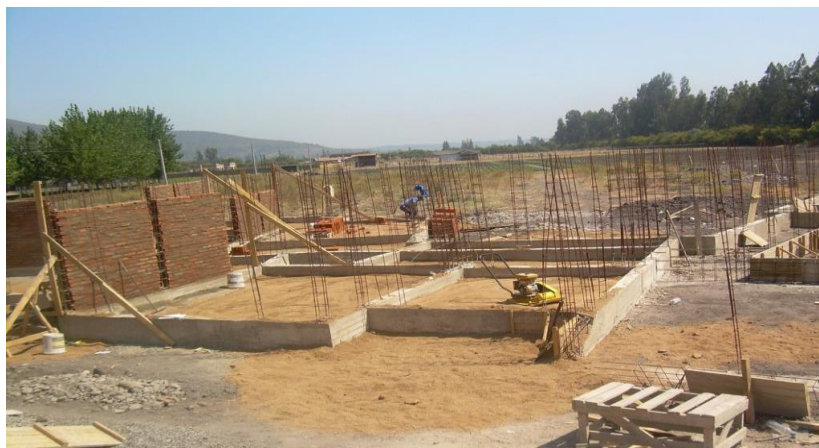
Figura 25. Sobrecimientos Nota. Fuente: (Abanto F. 2007) 14
