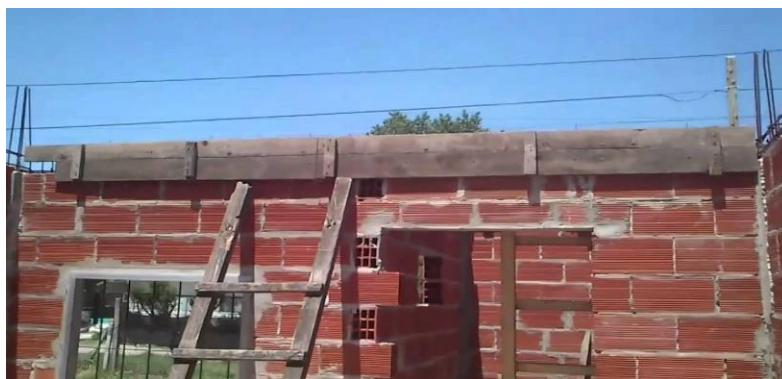
Figura 22. Viga solera Nota. Fuente: (Abanto F. 2007) 14
