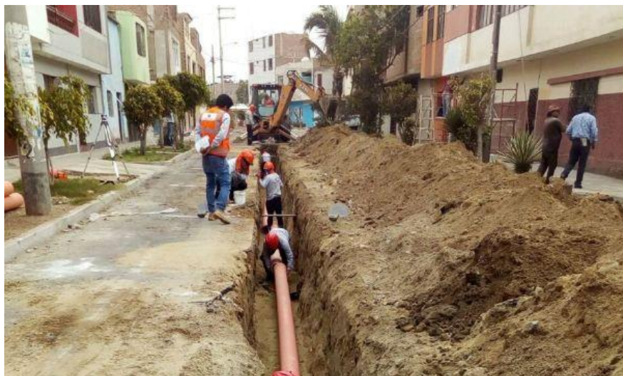
Figura 2.5: Instalación del Alcantarillado.
