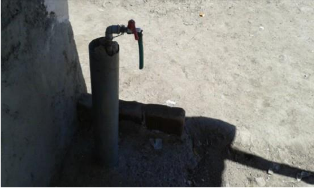
Figura 5.6: Obras existentes en la zona . Fuente: Elaboración propia.
