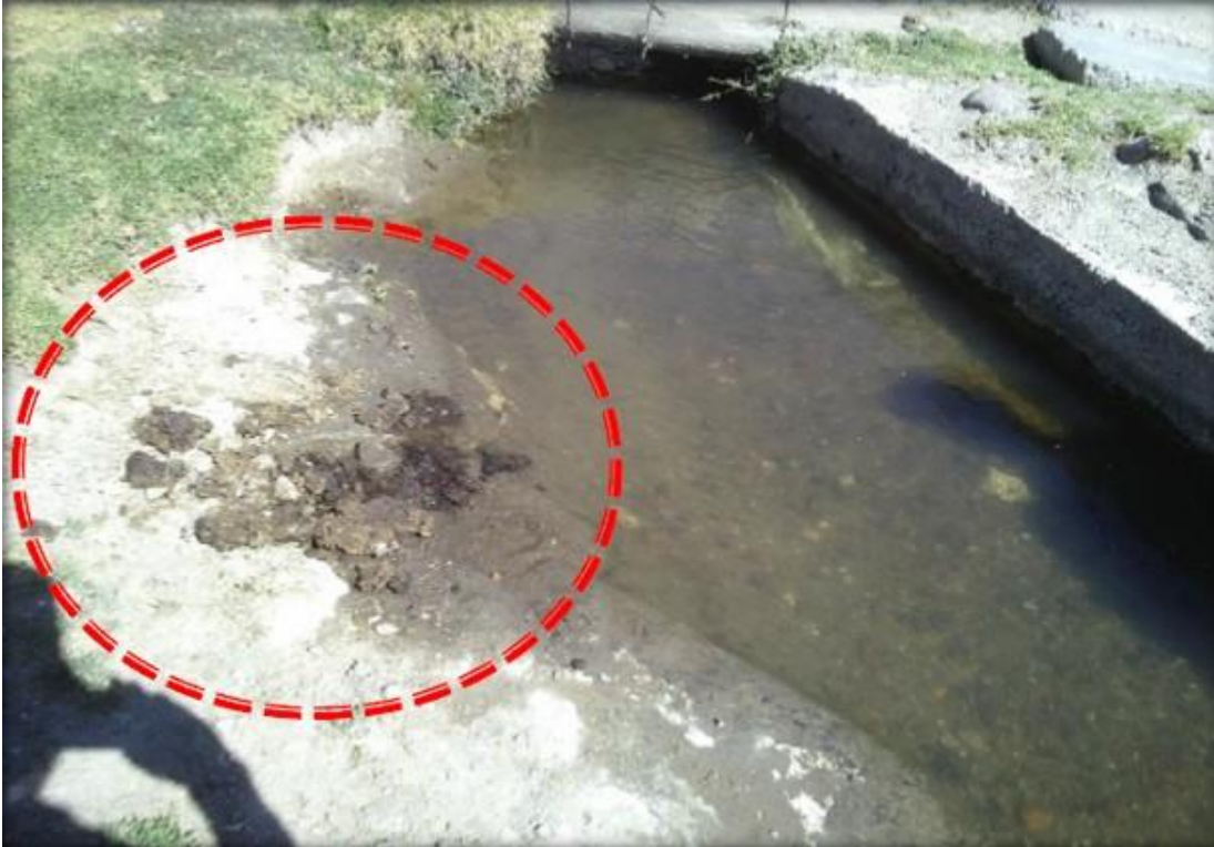
Figura 5.3: Estado actual del punto de captación. Fuente: Fuente propia.
