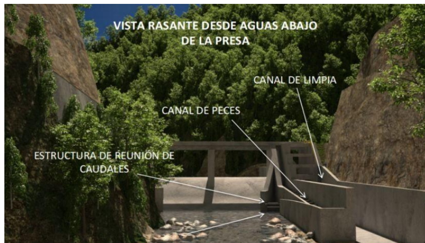
Figura 2.1: Obra de Captación de Agua. Fuente: Proyecto hidroeléctrico MIEL.
