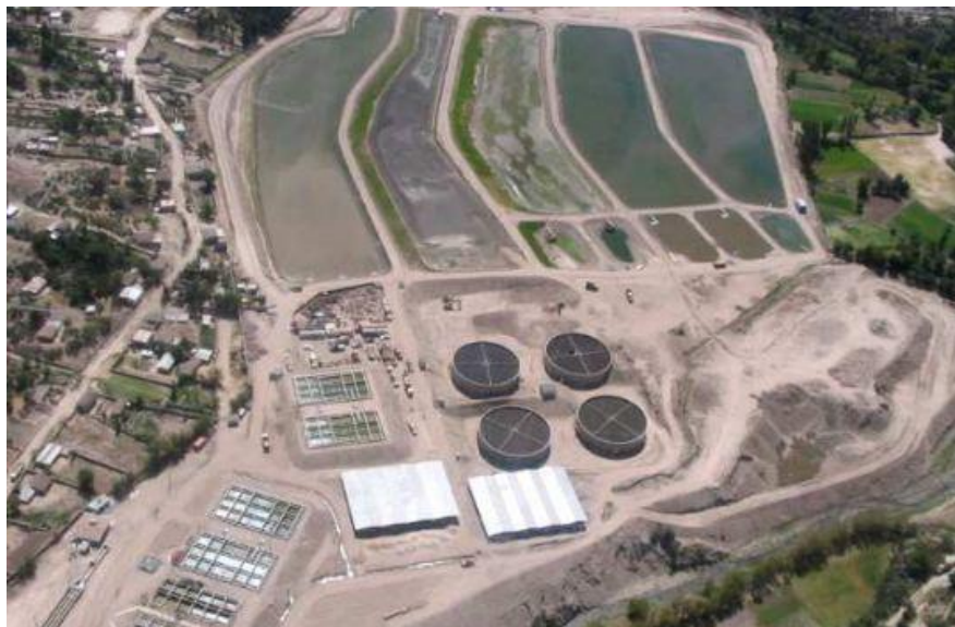
Figura 2.6: Planta de Tratamiento de Totorilla - Ayacucho.
