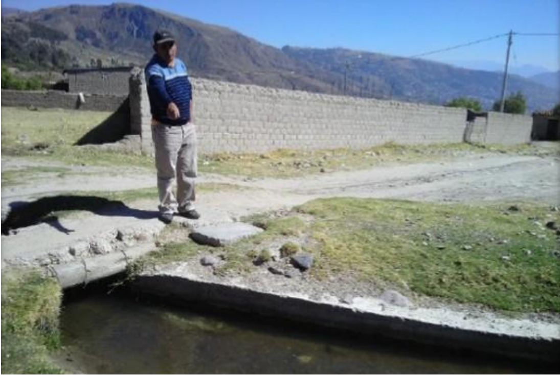
Figura 5.2: Estado actual del punto de captación. Fuente: Fuente propia.
