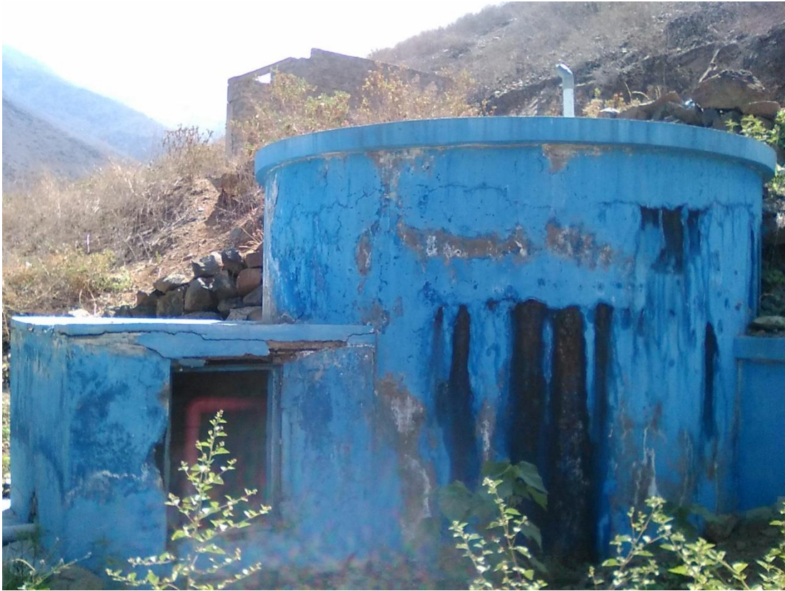
Fotografía 05: Evaluación Reservorio de almacenamiento. C.P Sam Miguel.
