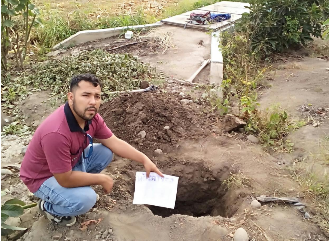
Fotografía 03: Calicata C .01, en el area de la captación.
