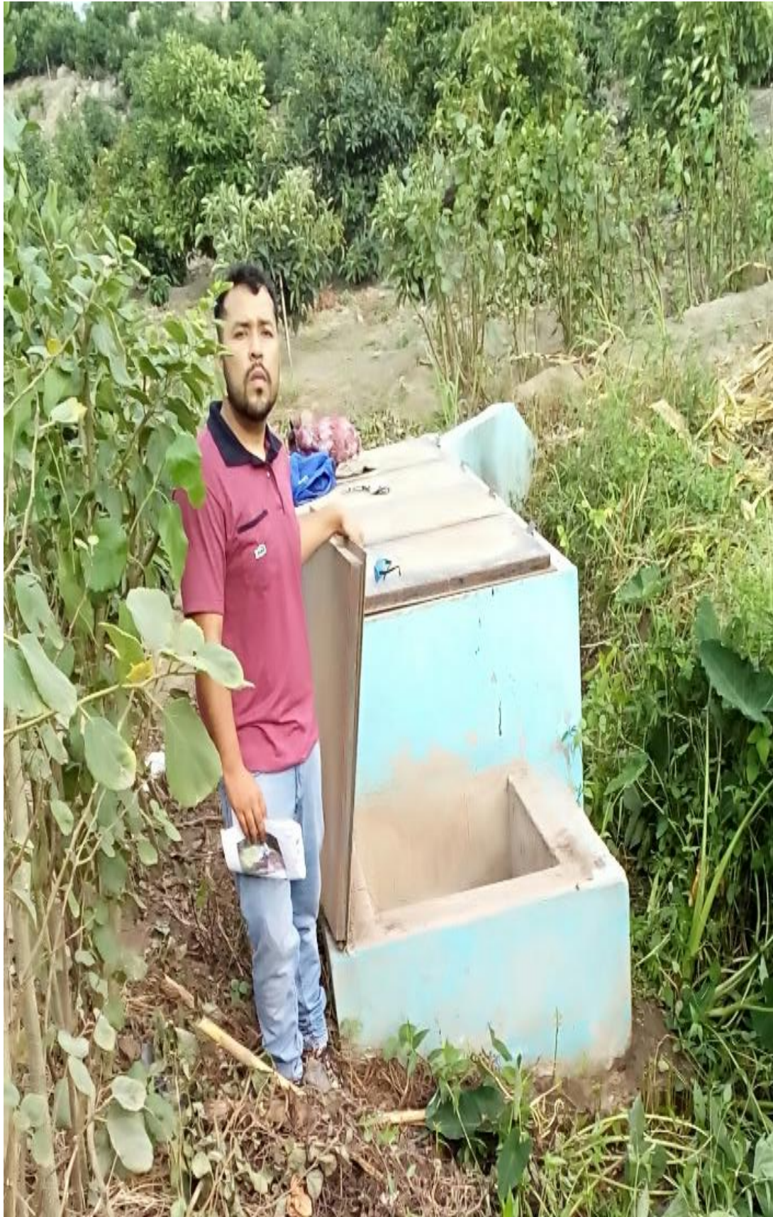
Fotografía 02: Realizando la evaluación a la cámara de captación en el C.P. San Miguel
