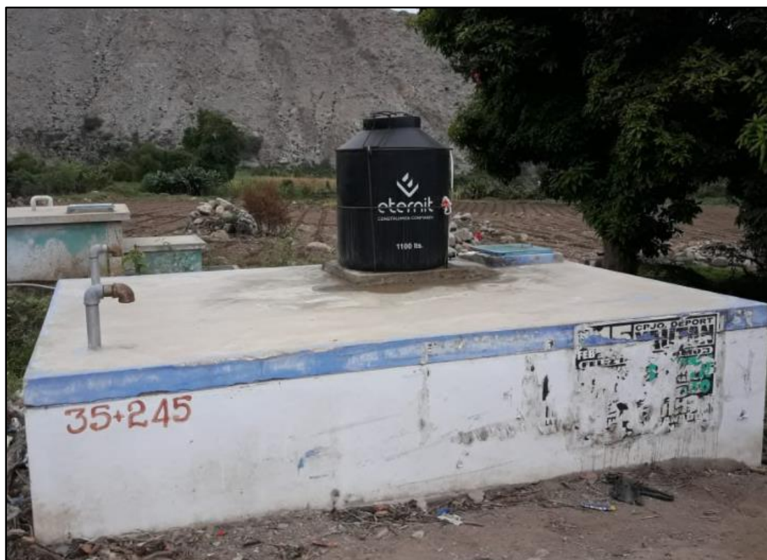
Imagen 14: Fotografía del reservorio existente
