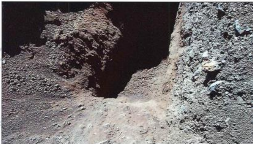
Foto N° 02.- En la toma se aprecia el detalle de la Calicata C-01.
