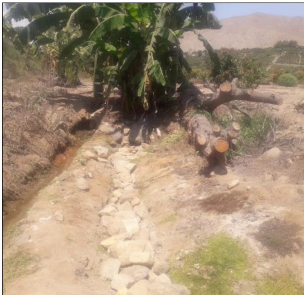
Imagen 12: Fotografía de tubería de conducción
