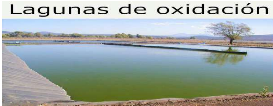
Figura N° 4 Laguna de Oxidacion
