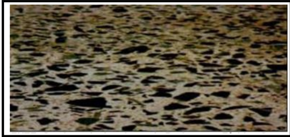
Figura 2.15: Pulimientos de la superficie. Fuente:(Castillo R. Rehabilitación de pavimentos rígidos . )
