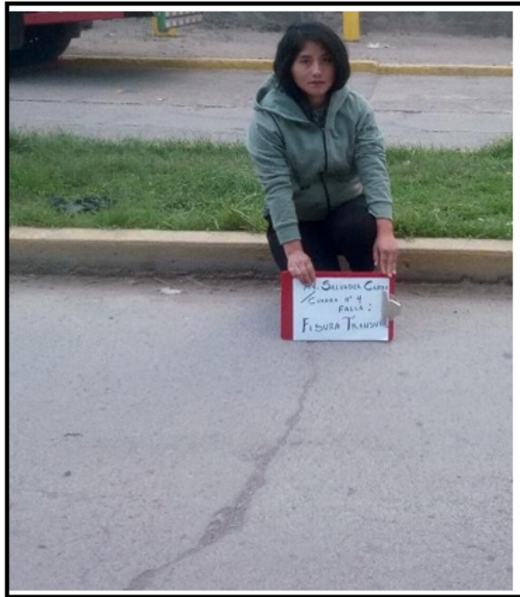
Fotografía 7: Fisura transversal.
