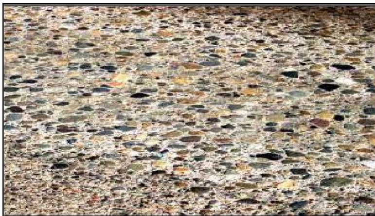
Figura 2.16: Patología por pulimento de agregados.
