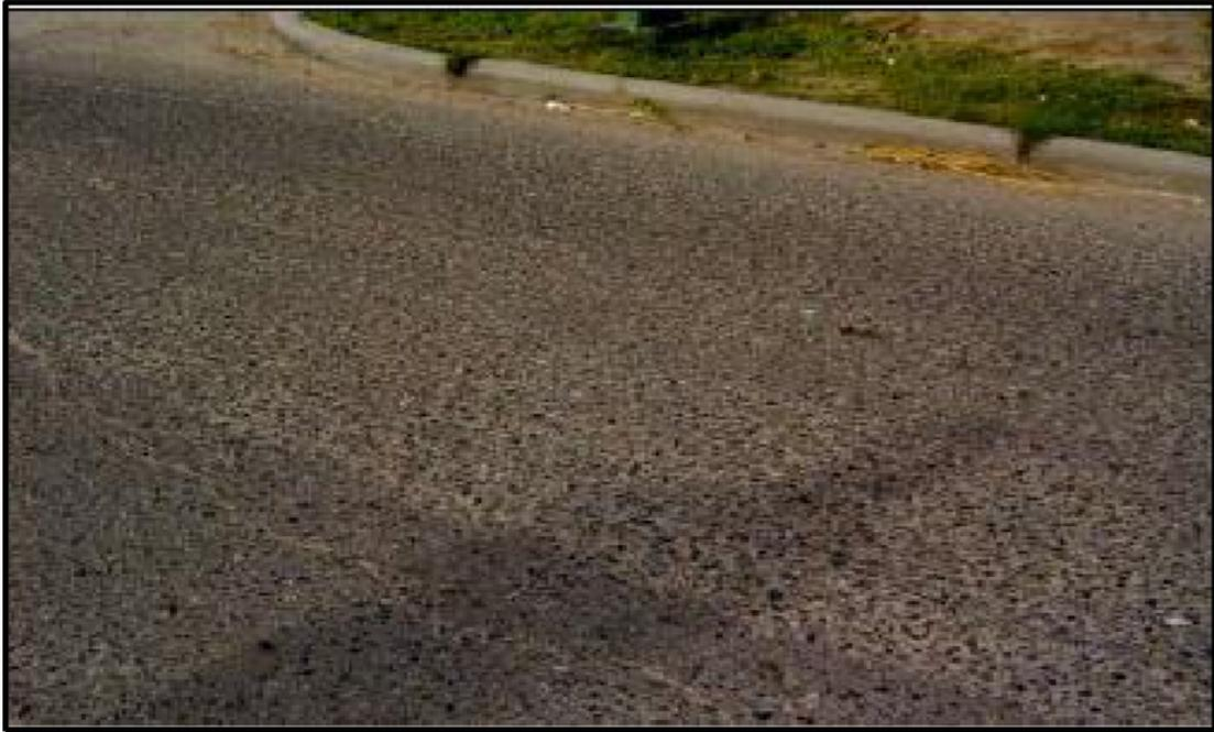
Figura 2.23: Patología por desprendimiento de agregados.
