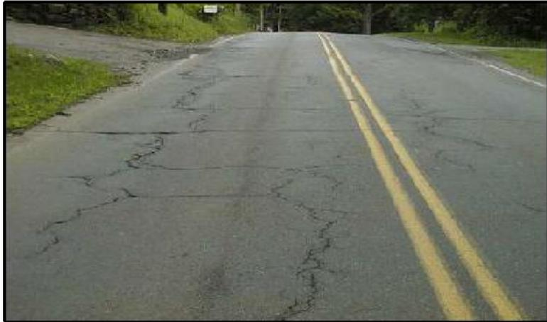
Figura 2.7: Patología por agrietamiento en bloque.
