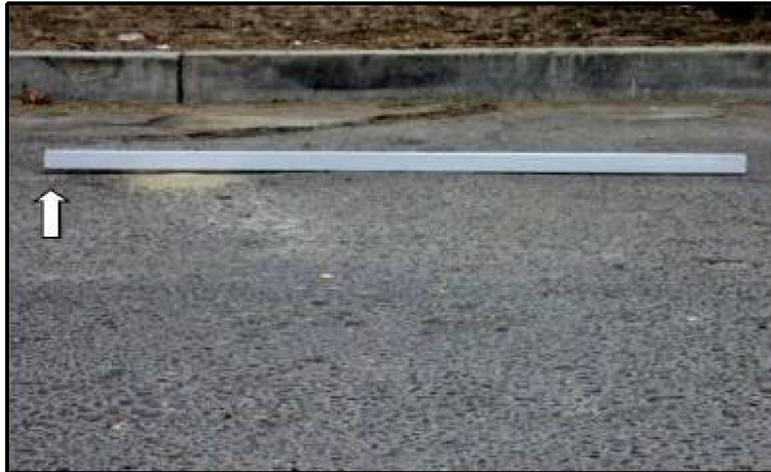
Figura 2.8: Patología por abultamiento y hundimiento.
