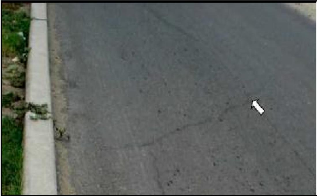
Figura 2.21: Patología por Grieta parabólica.
