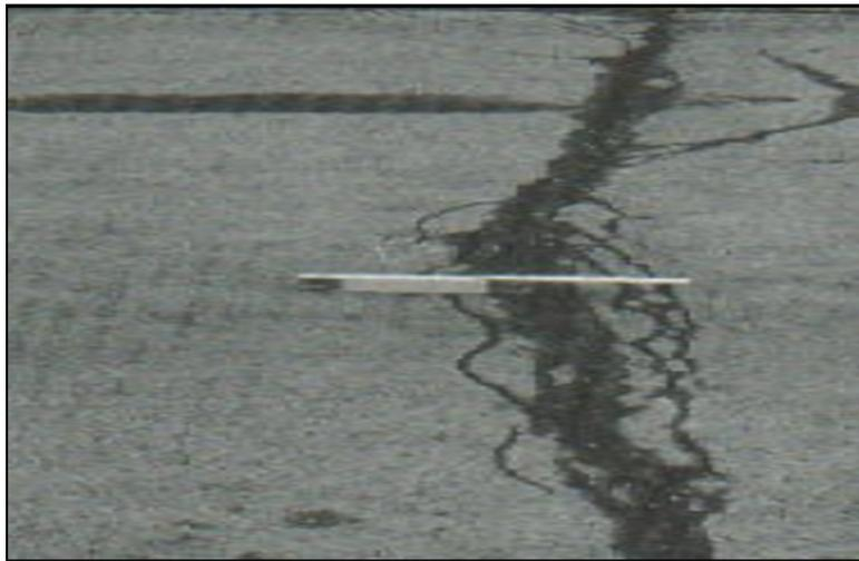
Figura 2.12: Patología por grieta de reflexión de junta.
