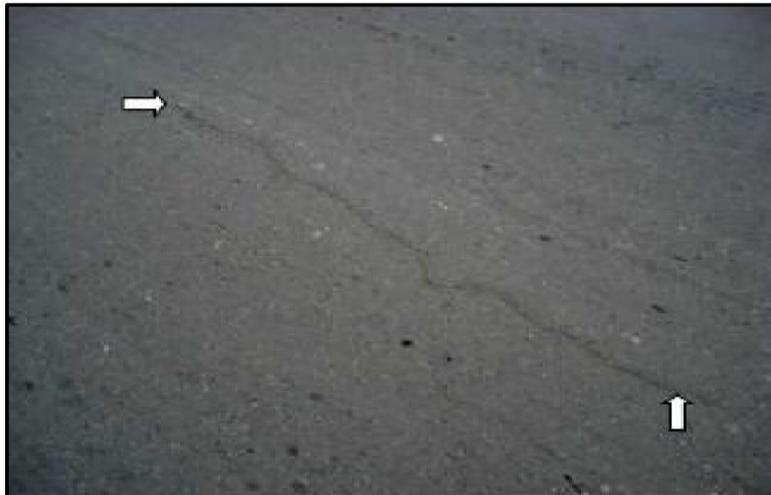
Figura 2.14: Patología por grietas longitudinales y transversales.
