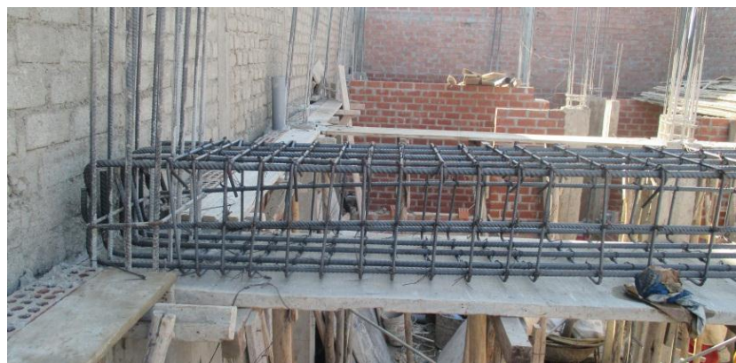
Figura 6. Viga en Albañilería Confinada de una Vivienda
