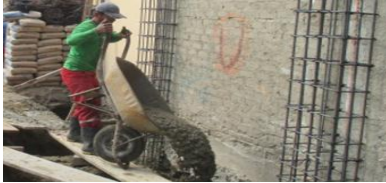
Figura 9. Vaciado de Concreto en una cimentación de una vivienda. Nota. Fuente: Elaboración Propia. (2017).
