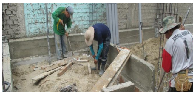
Figura 7. Sobrecimiento en Albañilería Confinada de una Vivienda. Nota. Fuente: Elaboración Propia. (2017).
