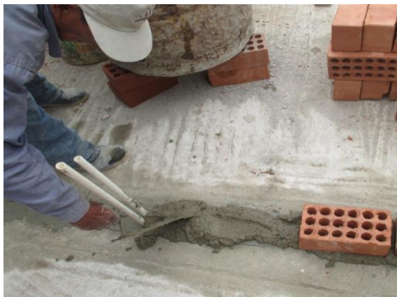
Figura 12. Colocación del mortero para el asentado de la unidad de albañilería.
