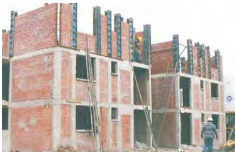
Figura 2. Albañilería confinada en proceso constructivo.
