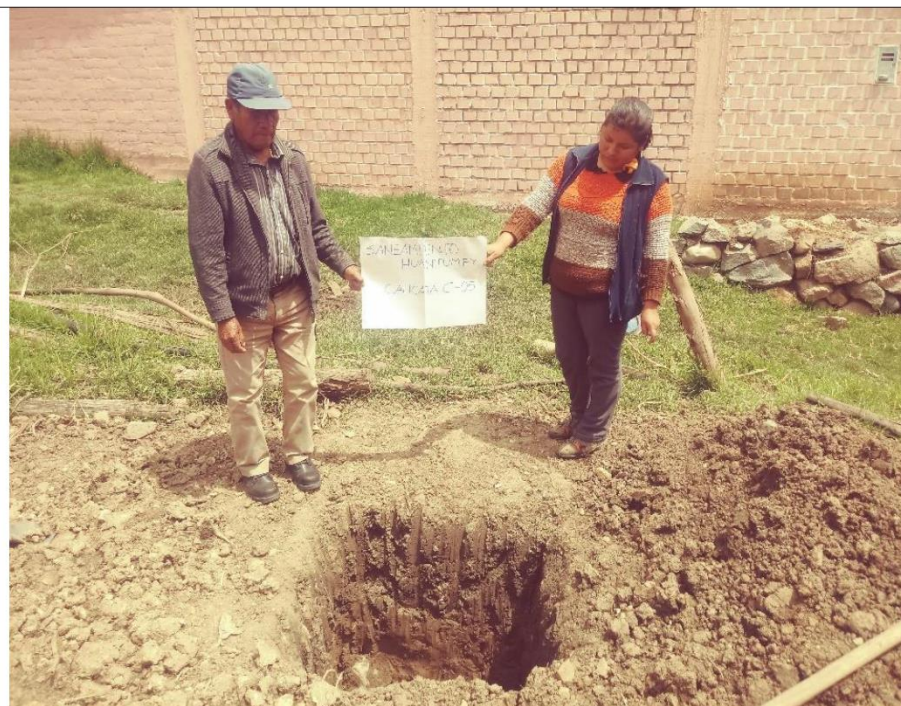
FOTOGRAFÍA N° 02: Vista realizando la toma de muestras de la calicata C-2.
