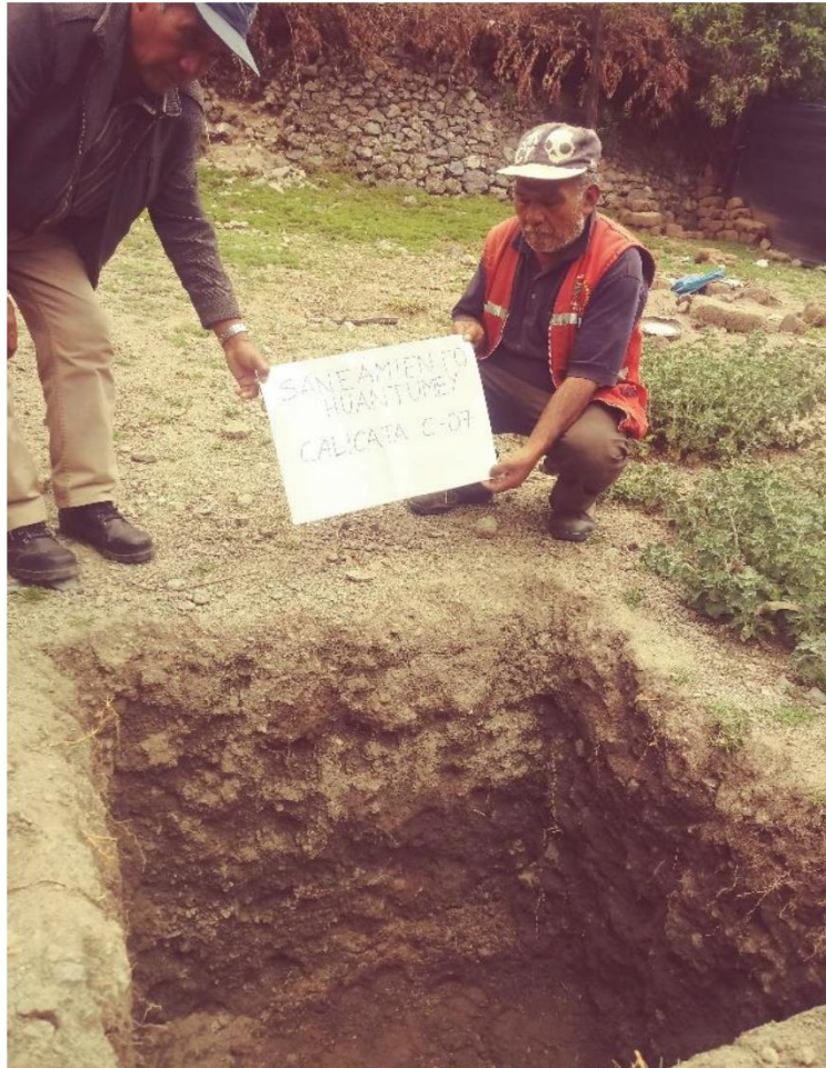
FOTOGRAFÍA N° 03: Vista realizando la toma de muestras de la calicata C-3.
