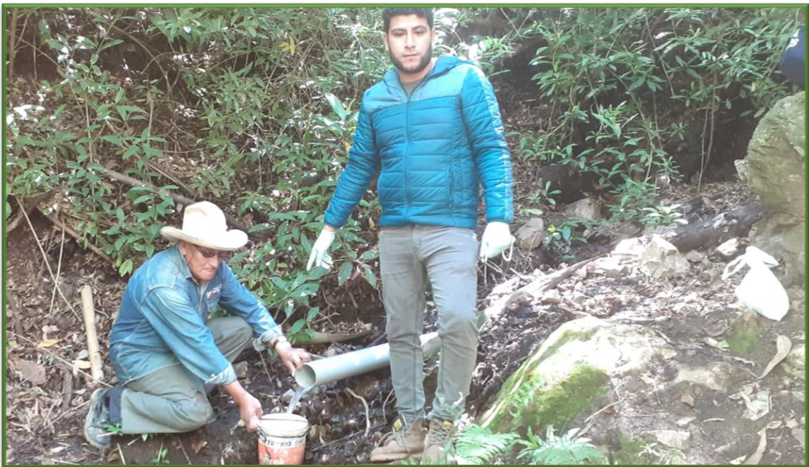
Fotografía N° 05: Realizando el aforo en el manantial del Centro Poblado de Huantumey.
