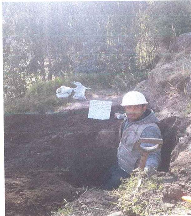
Foto N° 07.- Se aprecia una vista panorámica de la excavación de la calicata C-06. Lugar donde realizara el diseño de reservorio.
