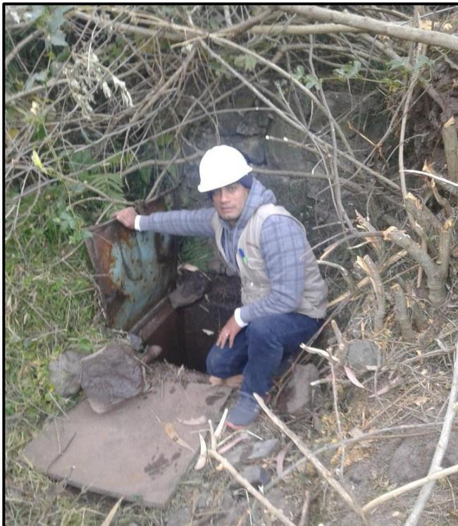
*Imagen 6: Cámara de captación en deterioro
