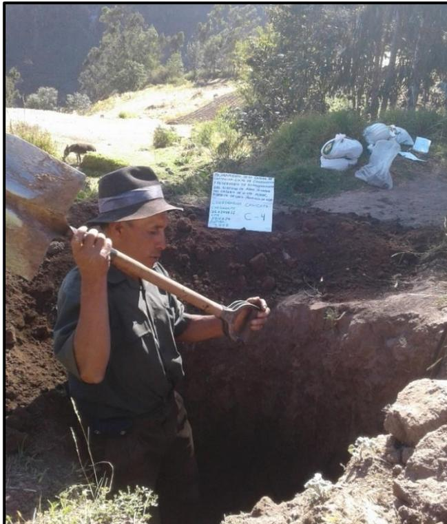
**Descripción:** En la imagen se puede apreciar la perforación de calicatas para determinar la capacidad portante del terreno calicata hecha en la línea de conducción, pobladores ayudan en la excavación de la calicata.
