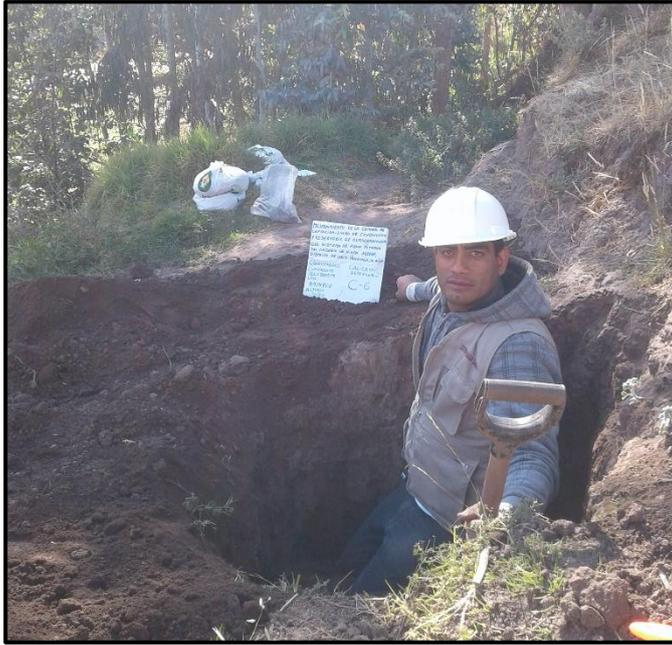
*Imagen 9: excavación de calicata reservorio de almacenamiento
