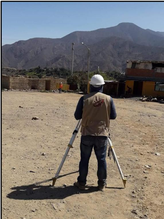
*Imagen 14: Levantamiento topográfico red distribución
